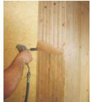
Versiegelung der Stirnflächen mit Holzmörtel.
