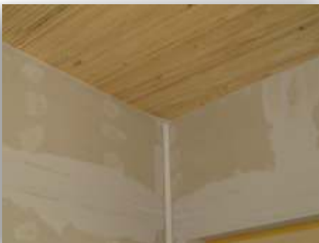
sichtbare PHE-Decke auf MHM-Wänden mit verspachtelten Gipskarton- Bauplatten
