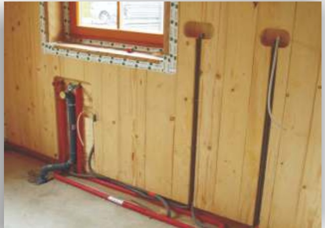
Elektro- und Wasserleitungen im Rohbau verlegt
