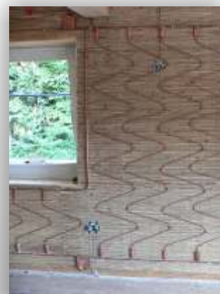
MHM- Wand mit Schilfmatten, Elektroinstallationen und Wandheizung fertig zum überputzen mit Lehm
