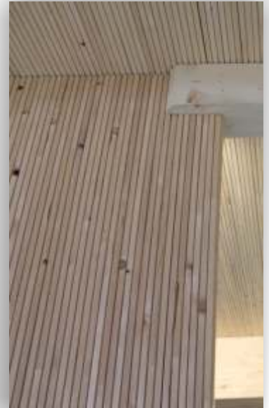
Profil-Holz-Elemente als Sicht- oberfläche an Wand und Decke
