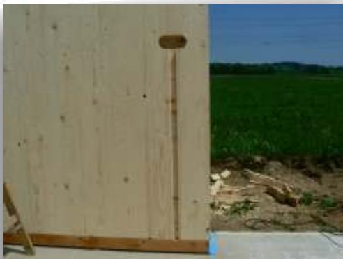
Die Elektrofräsungen sind in Wandelementen wie hier zu sehen ab Werk enthalten.
