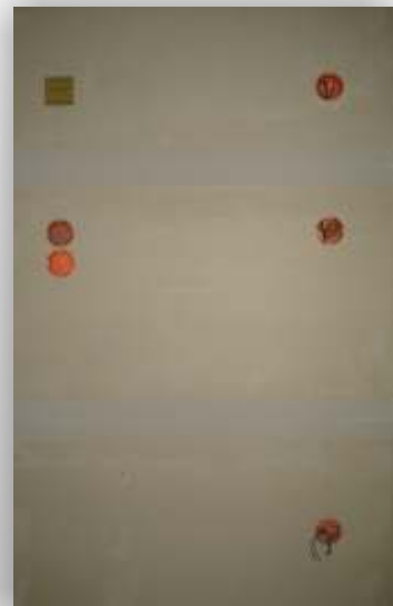
Installationsdosen in Gipskarton- Bauplatten
