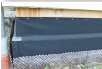
Sockelabdichtung mit EPDM-Bahn
