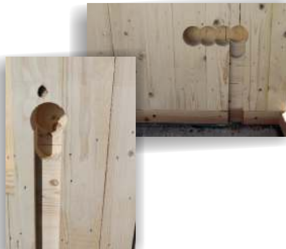
Eine zusätzliche Bohrung, welche in der Tiefe zwischen den Dosenbohrungen und dem Schacht liegt, sorgt für genügend Platz um Kabel hinter den Leerdosen hindurch führen zu können.
