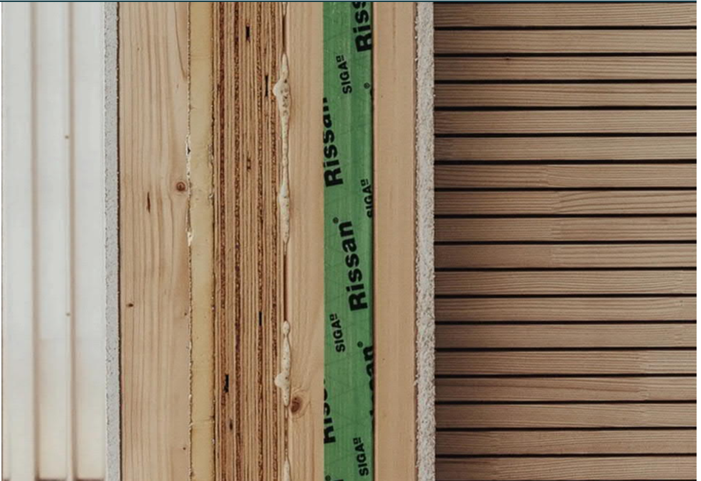
Unteransicht des Sturzes: Sturz und Decke sind mit dem Einsatz von Kerto LVL im L-Detail in eine Ebene
