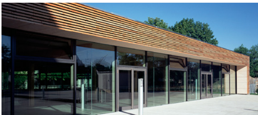
Abb. 10.18 Halle im Passivhausstandard
