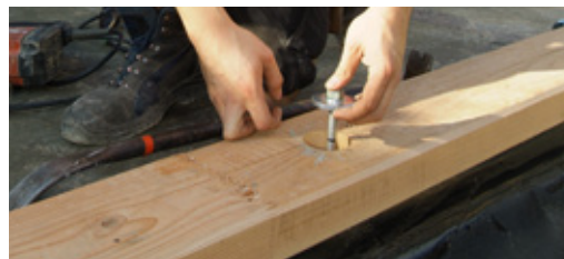
Abb. 4.24 Verankerung der Nivellierschwelle
