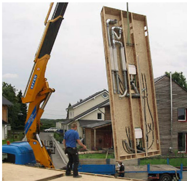
Abb. 3.07 Vorgefertigter Haustechnikschacht mit einseitiger Beplankung im „Kölner Holzhaus“: Einbau von oben durch die Geschossdecke des Erdgeschosses, Architekt: Robert Laur
