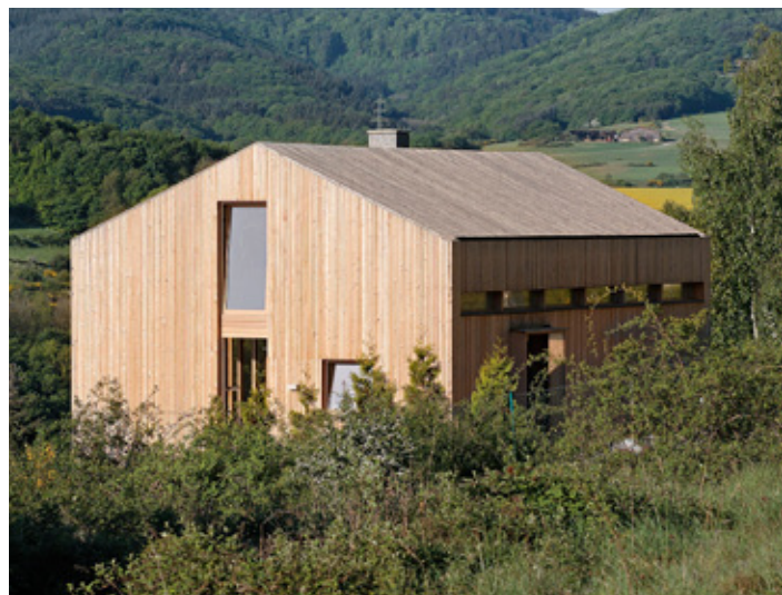
Abb. 2.08 Verschalung auf Lücke, Holzhaus in Schalkenbach / Eifel, Architekten: architektur_raum bauer u. sternberg
