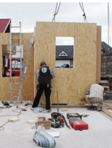
Abb. 3.05 Hebeeinrichtung für Holzbauteile
