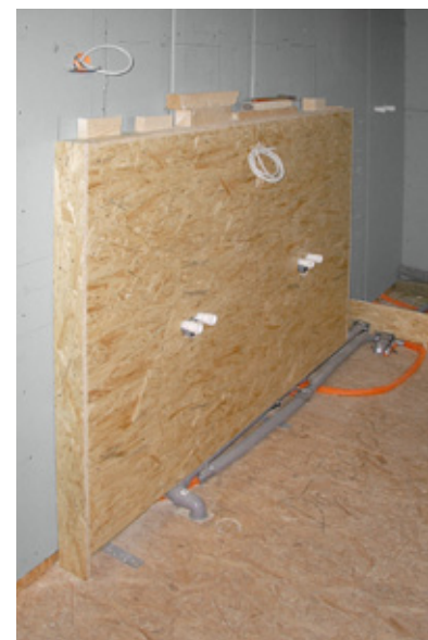
Abb. 6.04 Bekleidung einer Vorwandinstallation mit OSB-Platten
