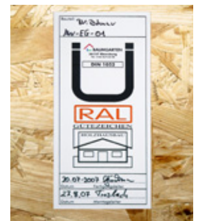
Abb. 1.19 Ü-Zeichen auf vorgefertigten Holztafelementen
