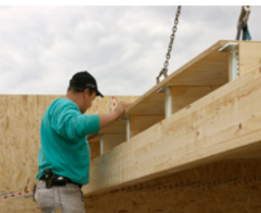
Abb. 3.06 Montage auf der Baustelle
