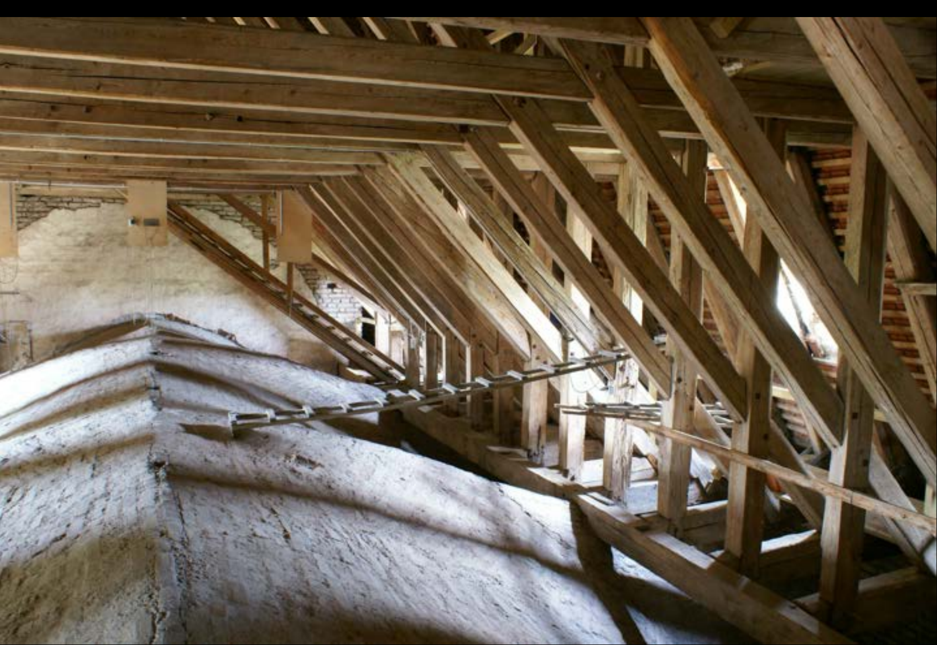
München, Maria Ramersdorf, Langhausdach (14. Jh.)
