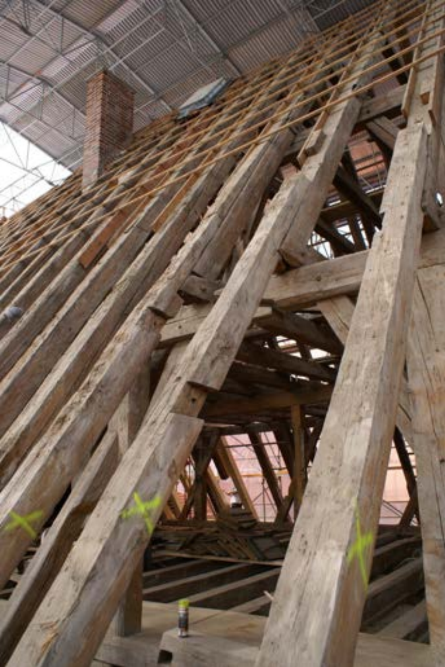
Dichte Gespärrefolge und Dachlattung (Beyharting, Klostergebäude)
