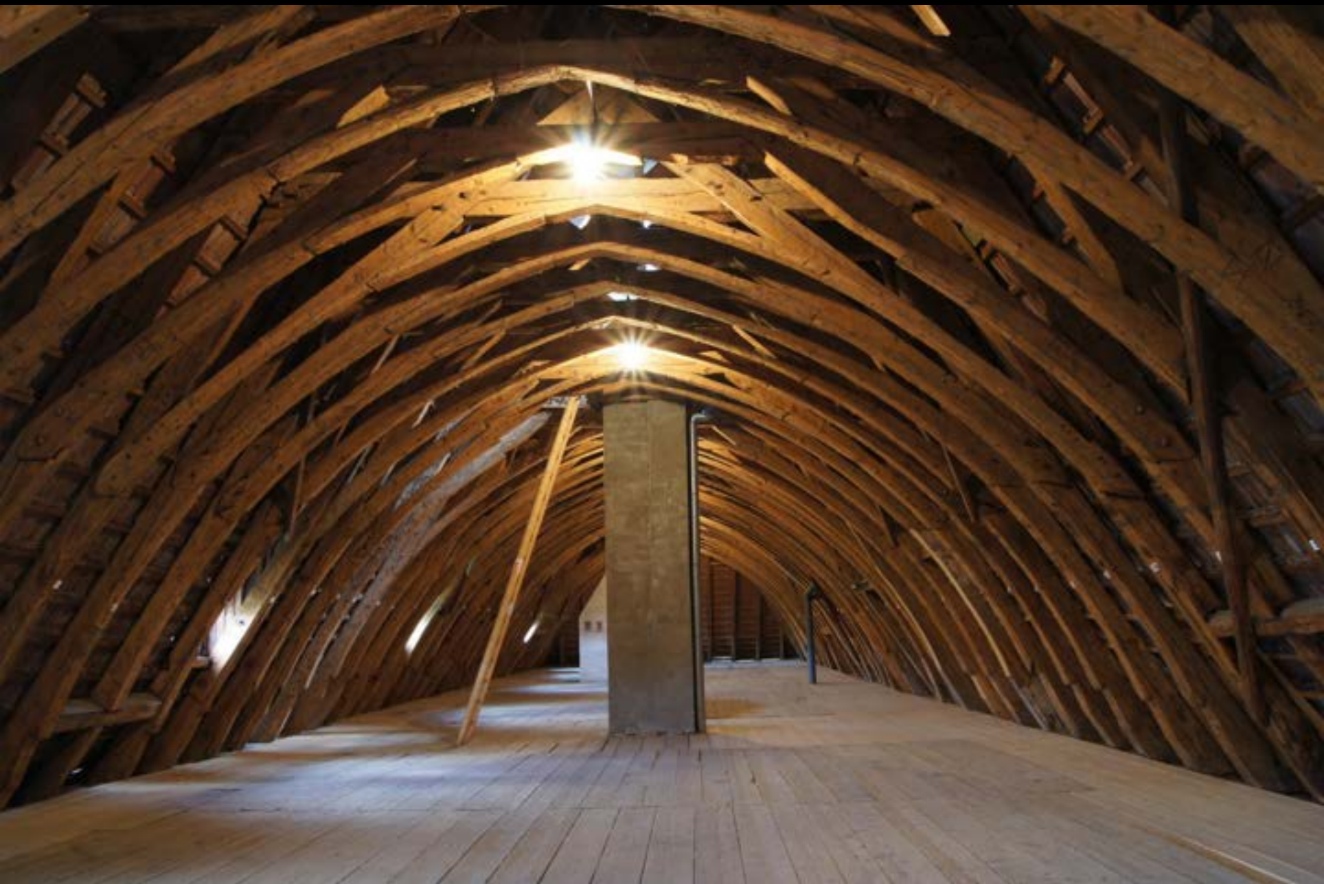
Kreuzstrebandach in Tonnenform (Erfurt, Predigerkloster, 1279)
