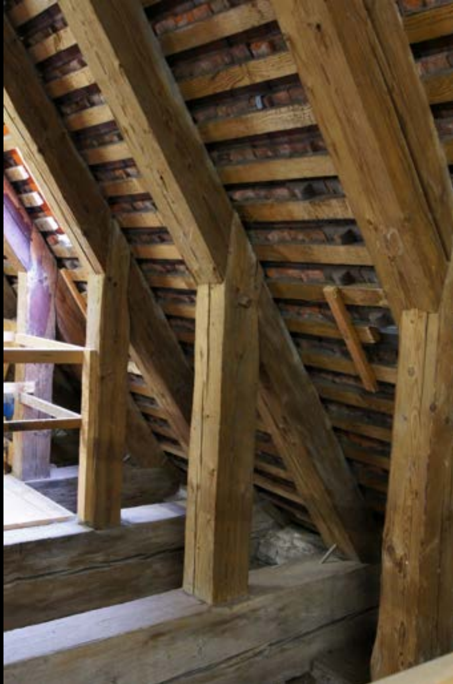
Gespärrefusspunkt mit Sparrenknechten (Augsburg, Dom, Langhaus, 15. Jh.)
