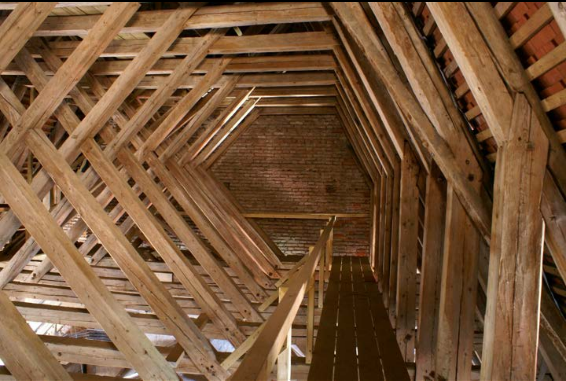
München, Maria Ramersdorf, Langhausdach (14. Jh.)
