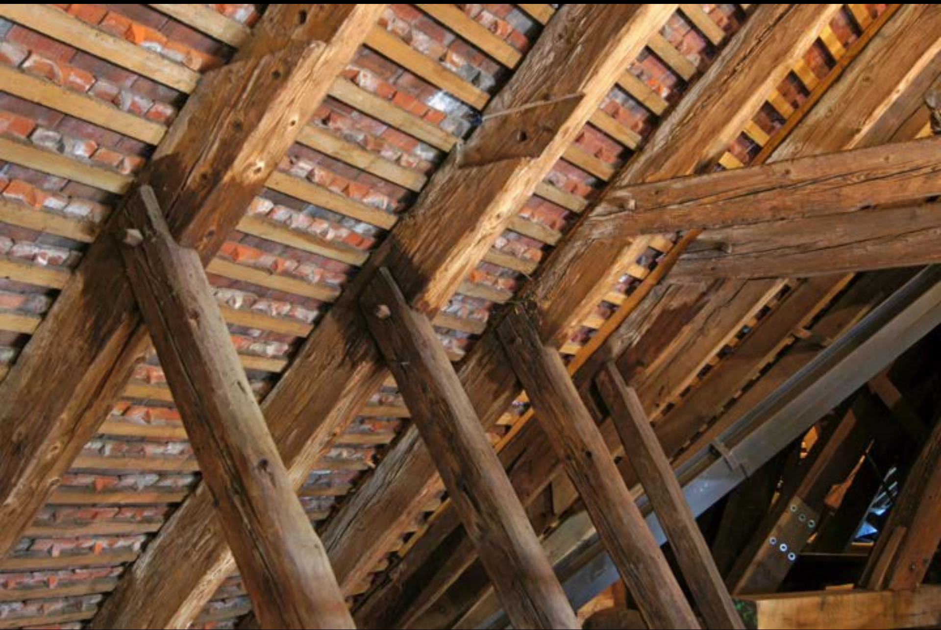
Dachwerk der Klosterkirche Maulbronn (1170d). Anblattung der Kehlbalcken und Sparrenknechte an den Sparren
