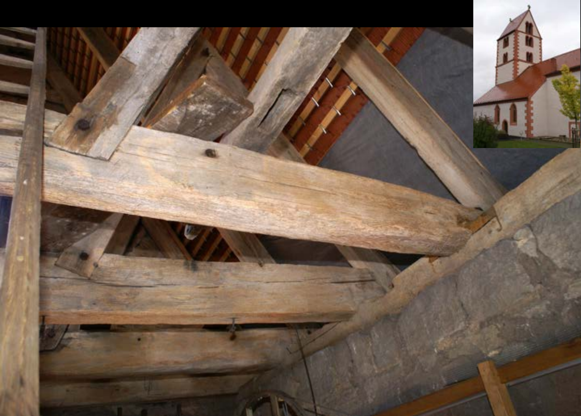
Anschlüsse am Zerrbalken (Brendlorenzen, Turmdach, 1260d)
