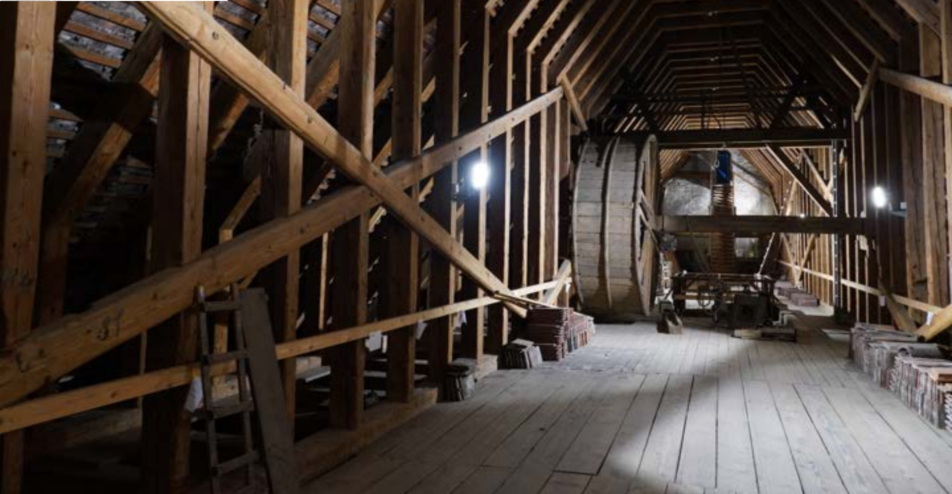
Dachwerk des Münsters Konstanz (1239d). „Ständerwand“ (poteaux) und Windrispen (contreventement)
