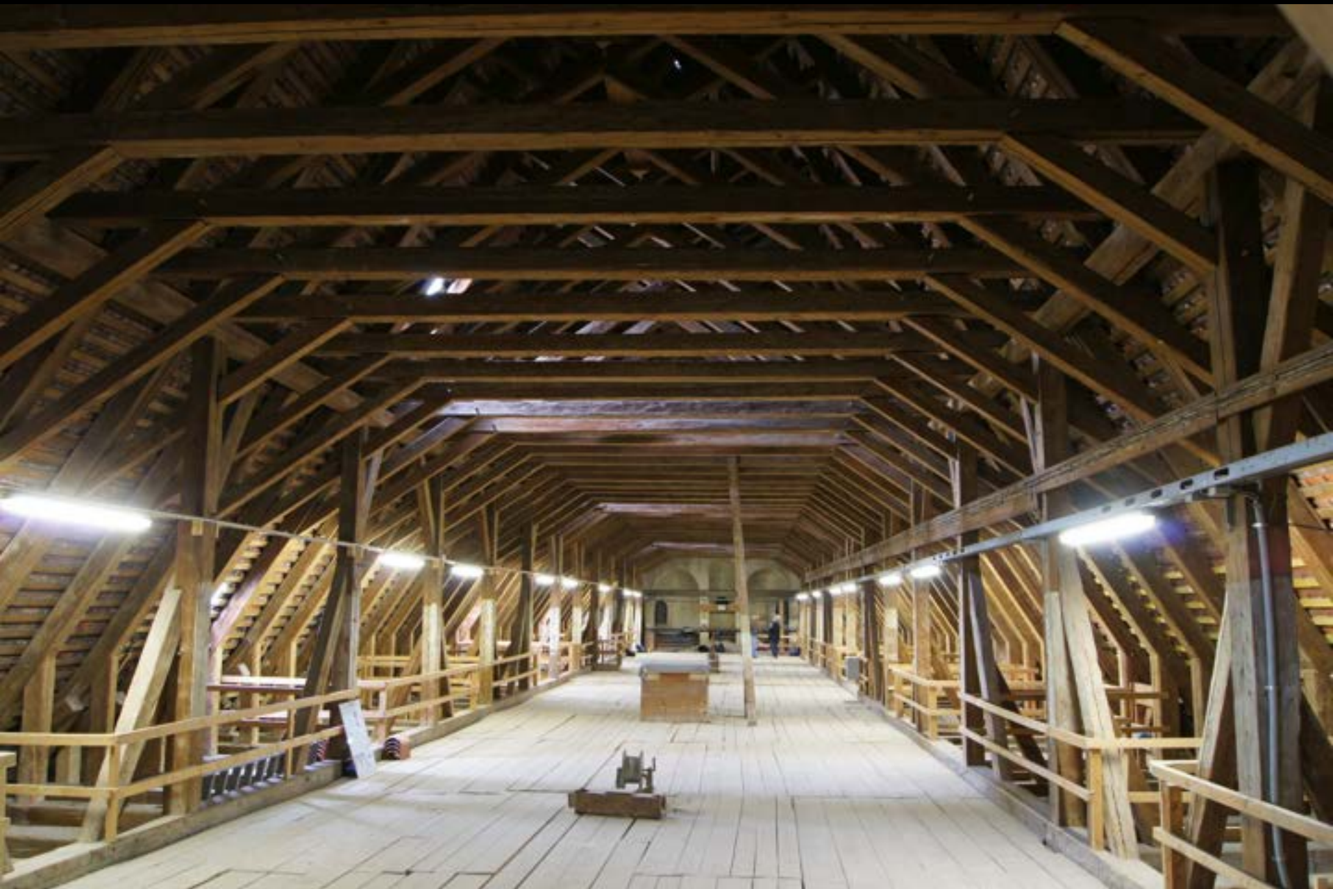
„Stehender Stuhl“ mit Reihung identischer Gespärre (Augsburg, Dom, Langhaus, 15. Jh.)
