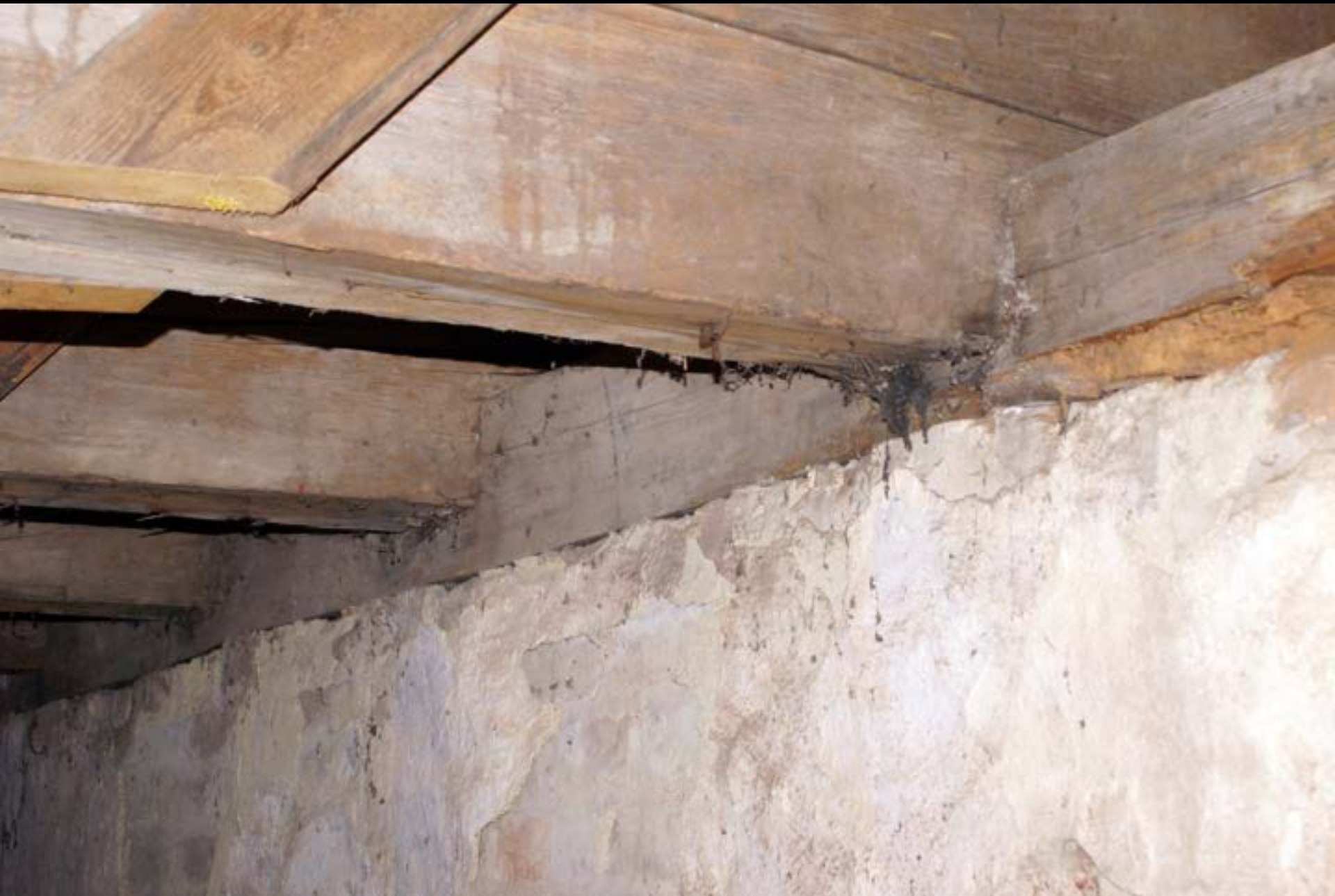
Anschluss Zerrbalken-Mauerlatte (Freising, Dom, 1227)
