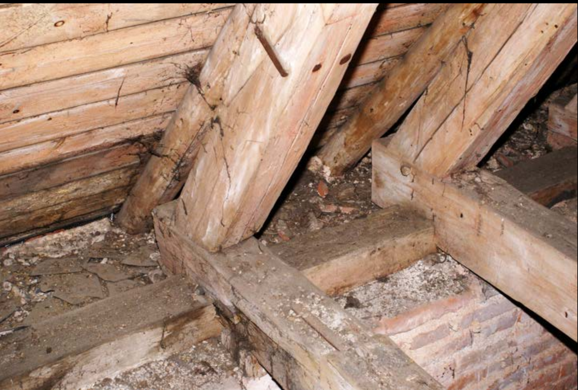
Mauerlatte und Gespärre, Aufschieblinge (Möschenfeld)
