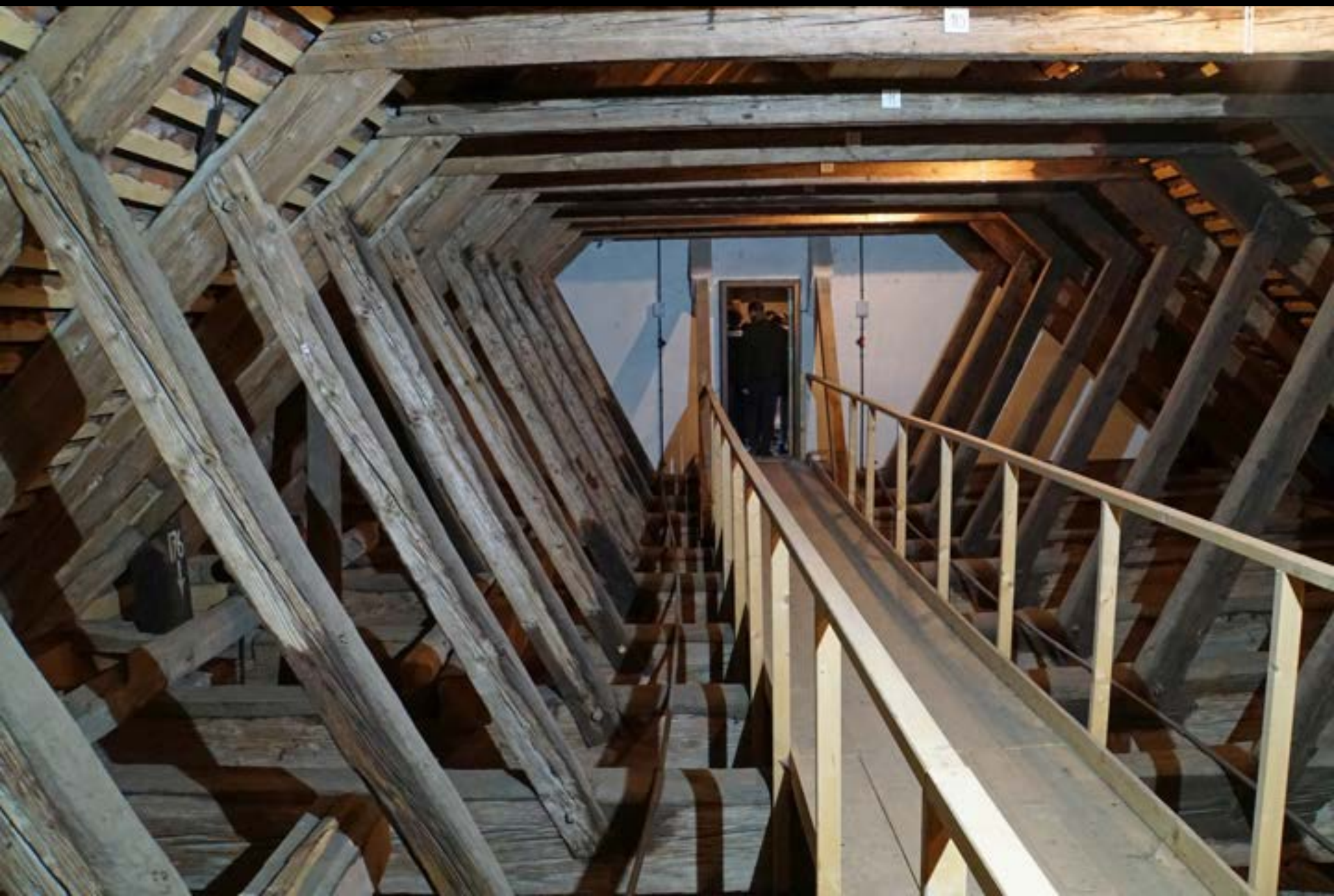
Dachwerk der Klosterkirche Maulbronn (1170d)
