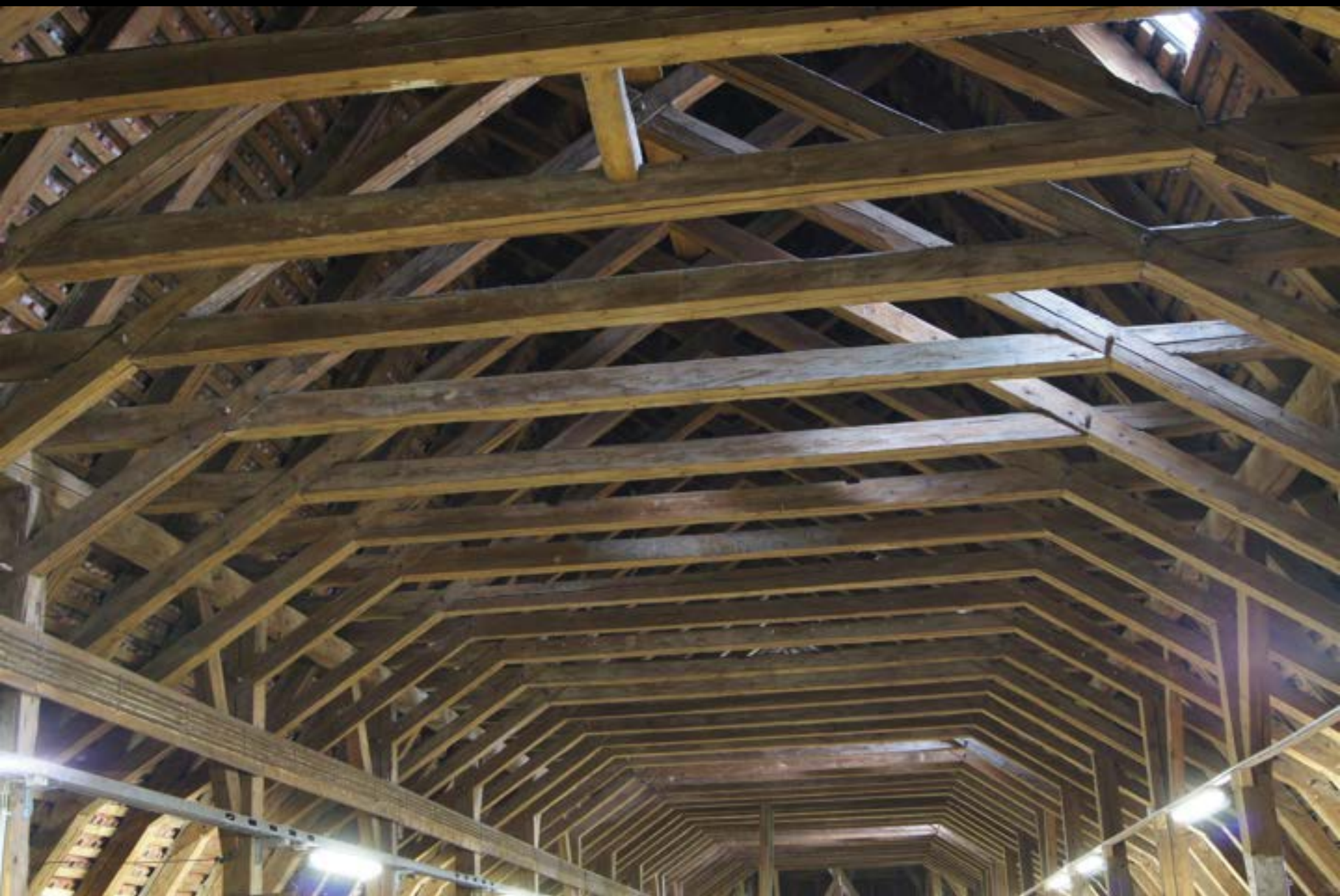
„Stehender Stuhl“ und Kreuzstrebendach (Augsburg, Dom, Langhaus, 15. Jh.)
