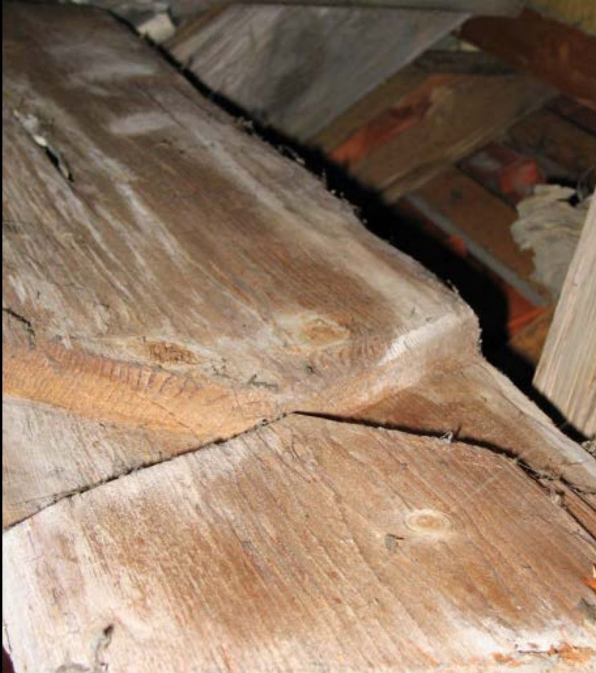
Verbindung zwischen Mauerlatte und Gespärre: Kreuzkamm
