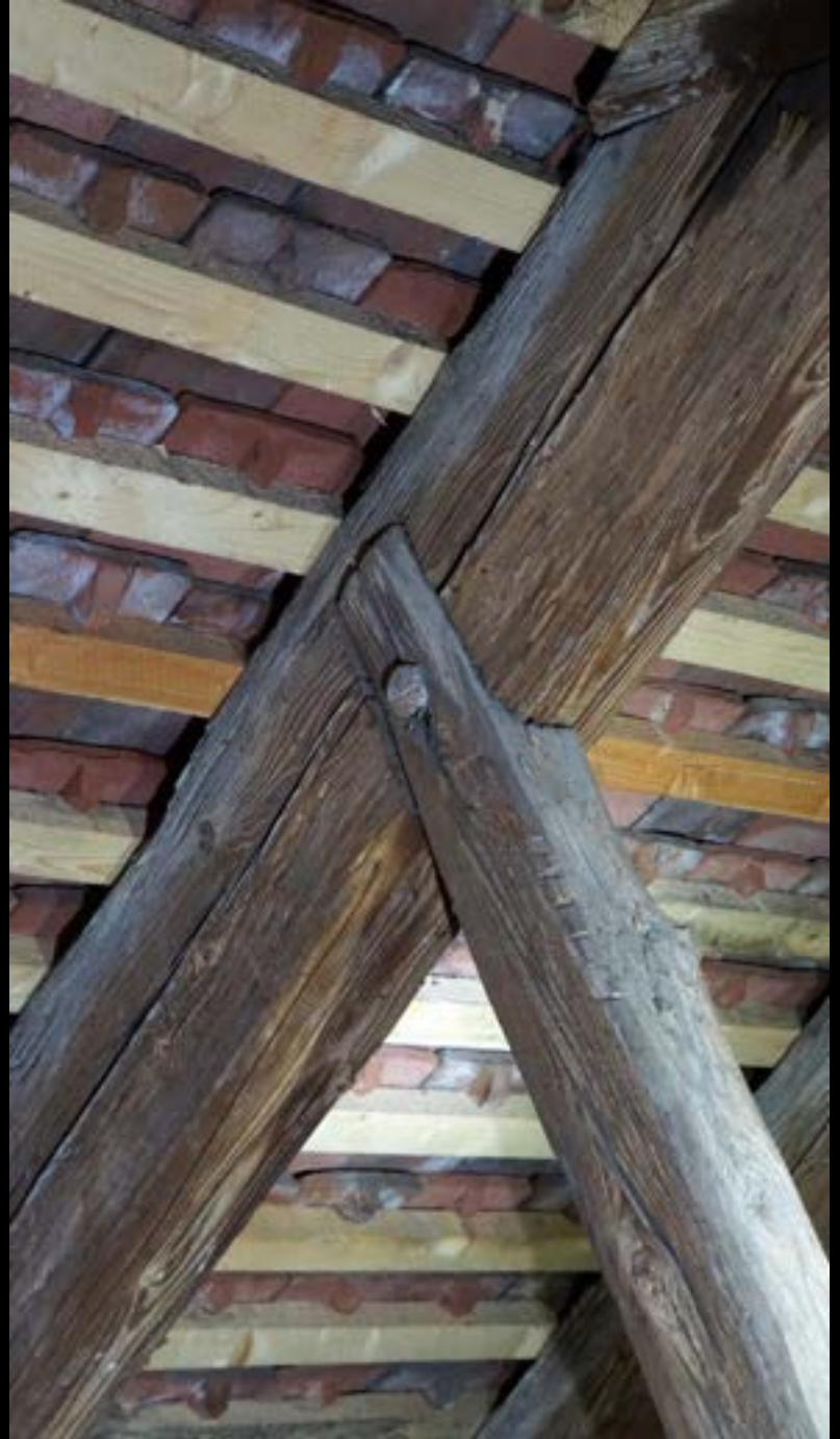
Dachwerk der Klosterkirche Maulbronn (1170d). Anblattung der Kehlbalken und Sparrenknechte an den Sparren
