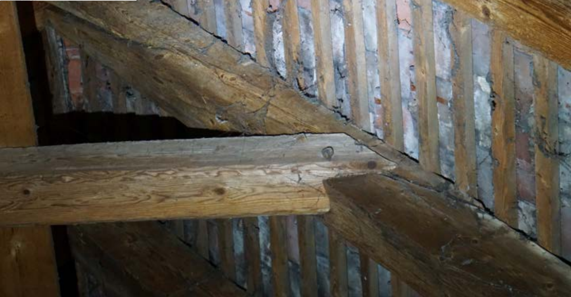
Dachwerk des Münsters Konstanz (1239d): Hahnenbalken (Kehlbalken)
