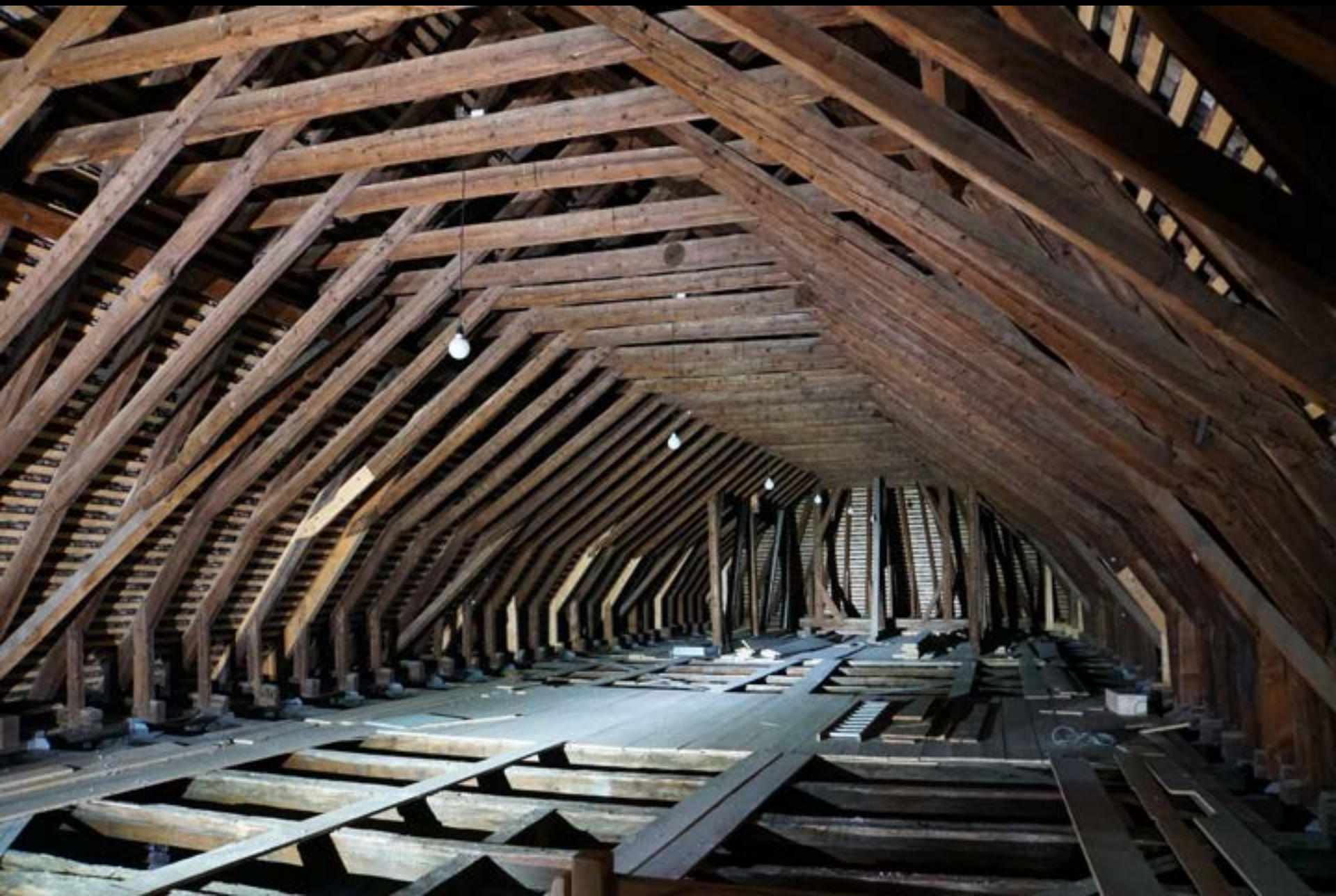
Kreuzstrebindach: Stichbalken und Ankerbalkenlage (Basel, Grosses Klingenthal, 13. Jh.)
