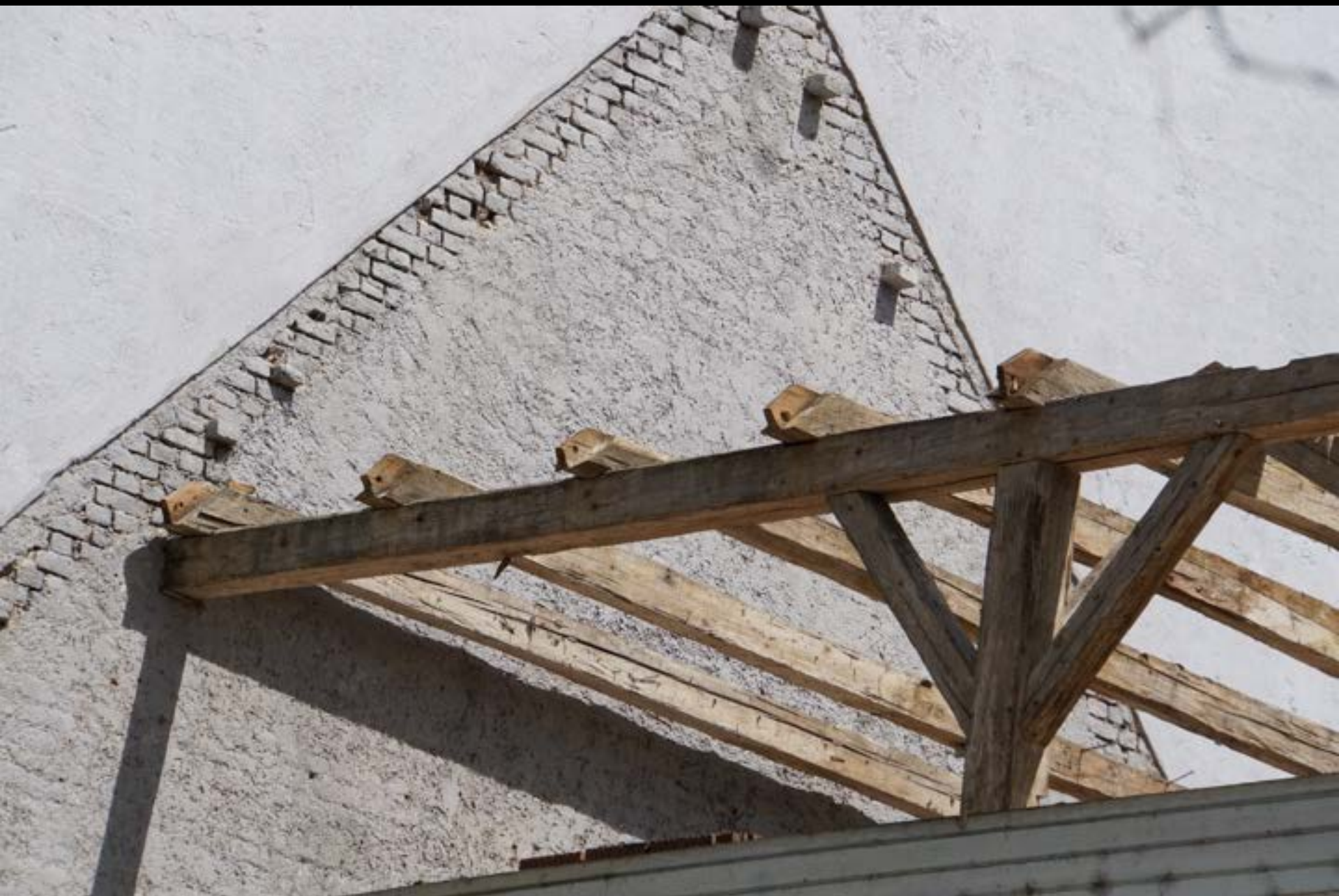
„Stehender Stuhl“ als Aufbauhilfe: Kehlbalken als Arbeitsebene
