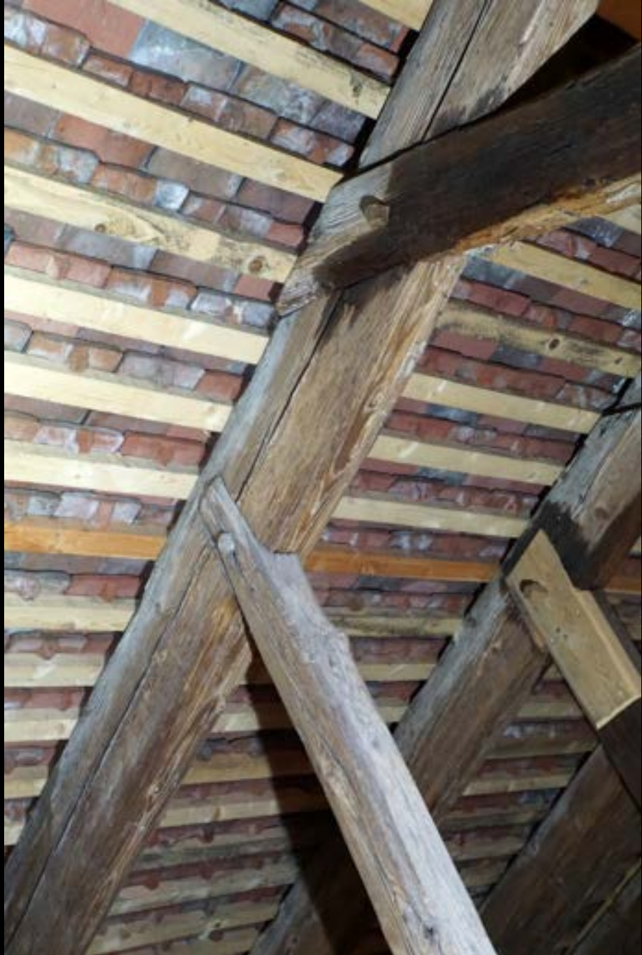
Dachwerk der Klosterkirche Maulbronn (1170d). Anblattung der Kehlbalken und Sparrenknechte an den Sparren
