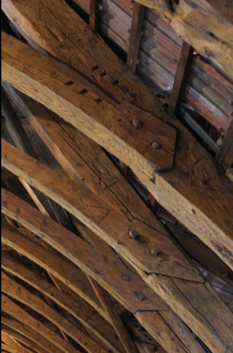
Kreuzstrebdach in Tonnenform (Erfurt, Predigerkloster, 1279)
