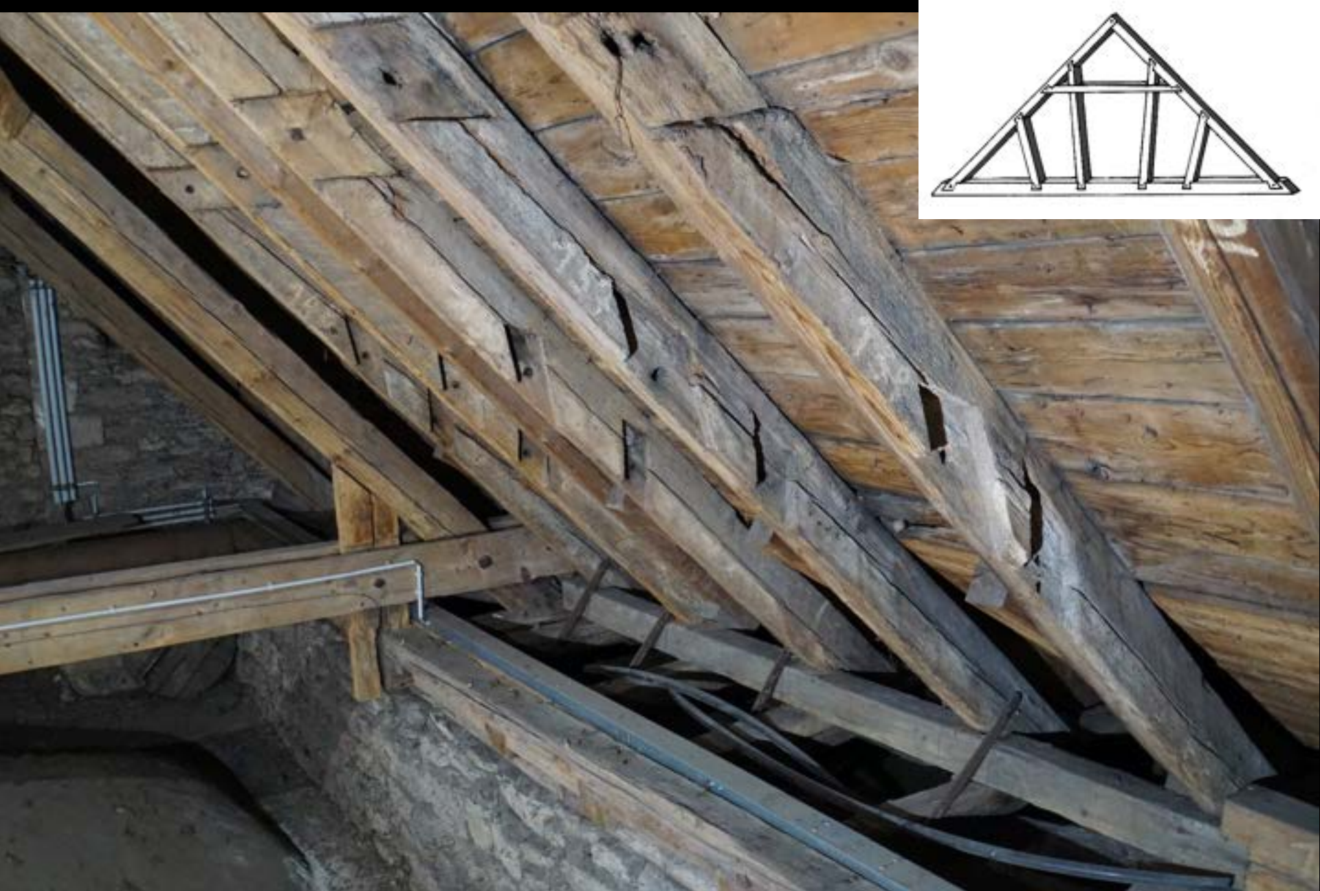
Relikte eines Dachwerks mit Kehlbalken und mehreren Sparrenknechten (Limburg/Lahn, Dom, Südquerhaus, um 1220)
