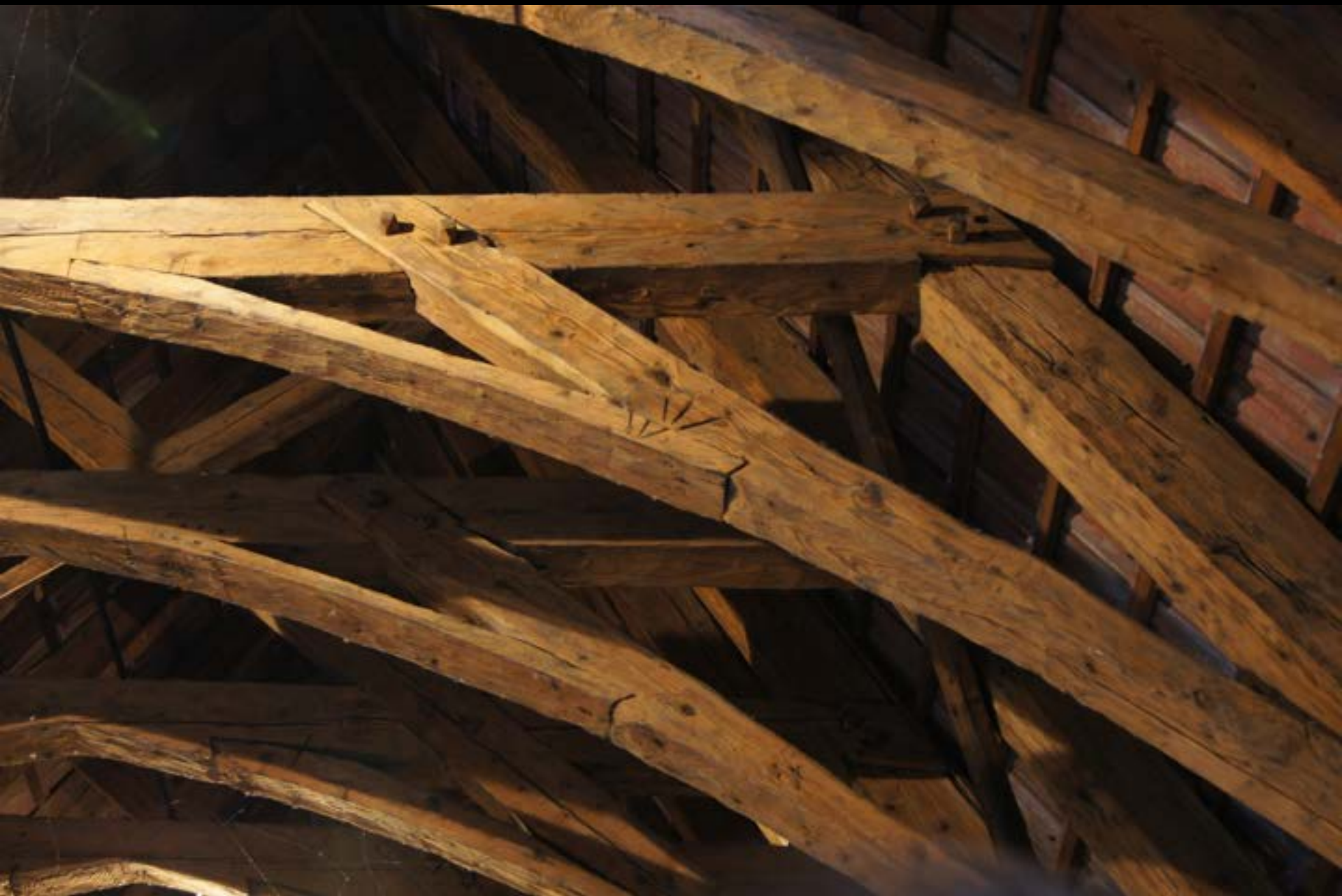
Kreuzstrebindach in Tonnenform (Erfurt, Predigerkloster, 1279)
