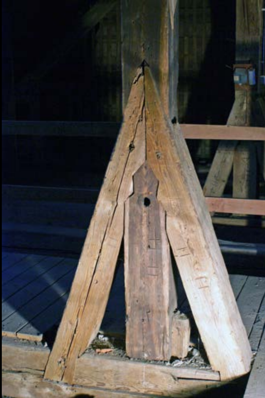
Hängesäule – Anschlüsse
