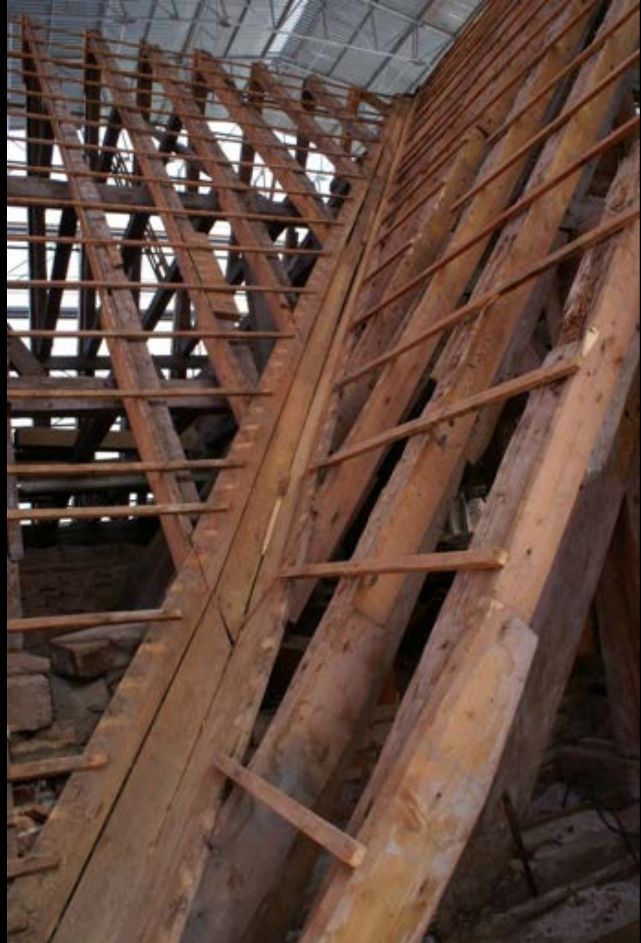
Dichte Gespärrefolge und Dachlattung (Beyharting, Klostergebäude)
