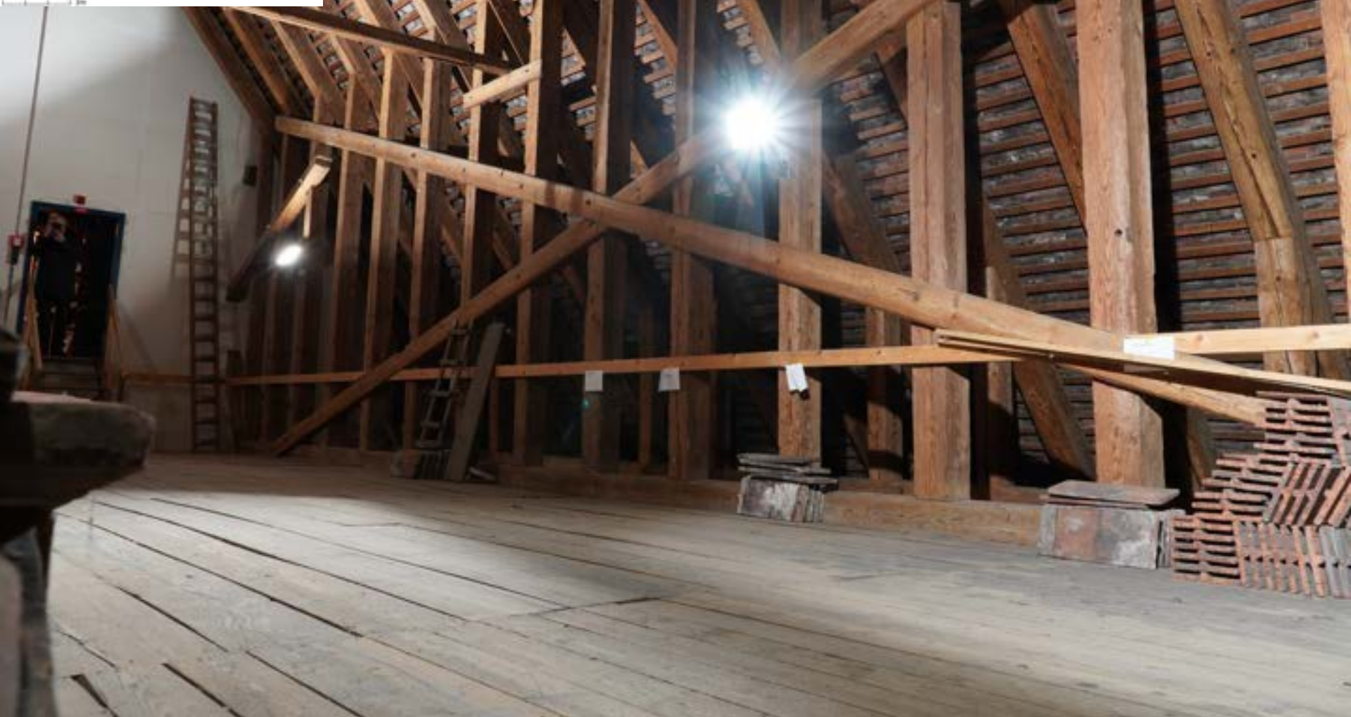
Dachwerk des Münsters Konstanz (1239d). „Ständerwand“ und Windrispen
