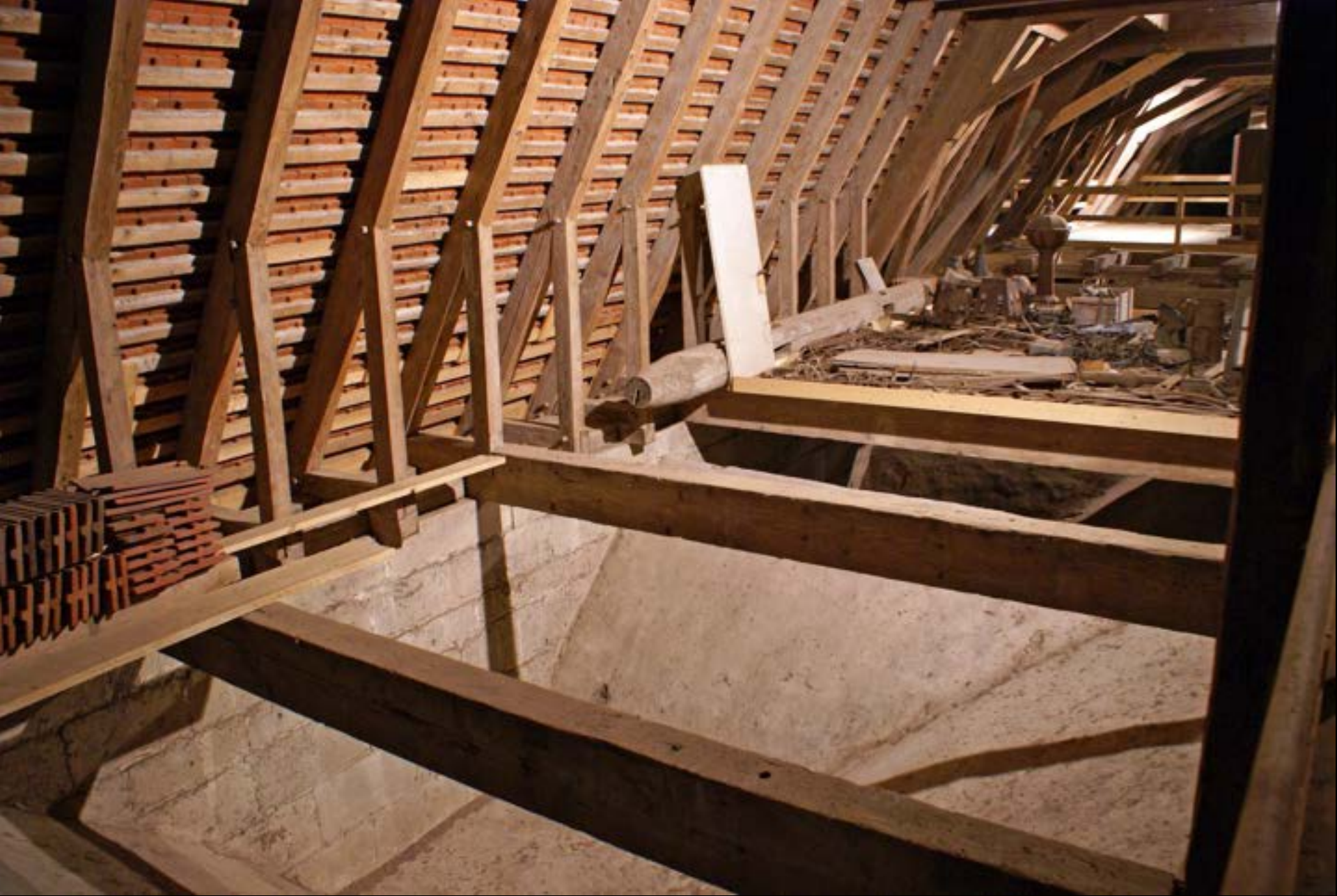
Dachwerk der Abteikirche Salem (frühes 14. Jh.): Nur jeder 3. Zerrbalken geht durch!
