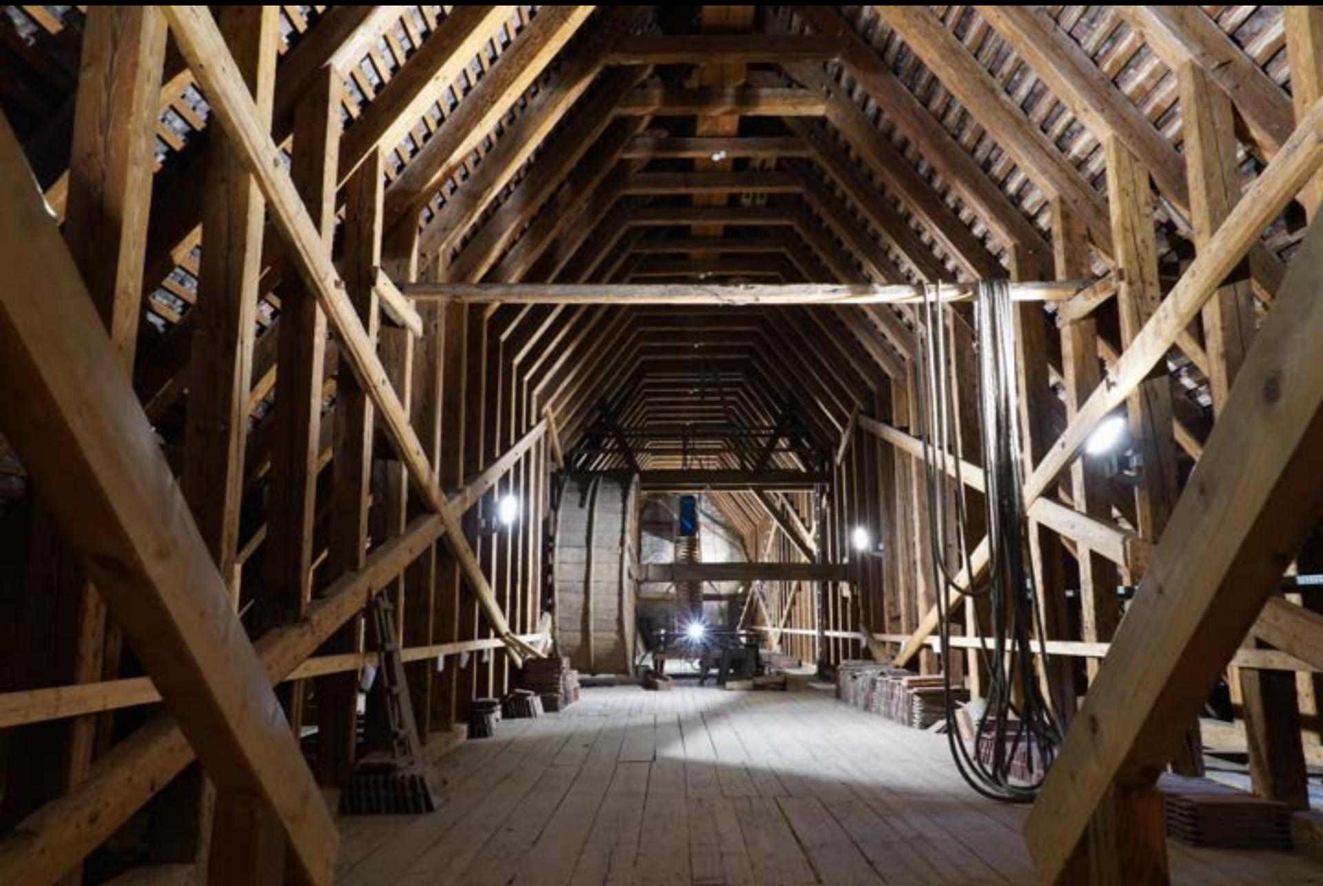
Dachwerk des Münsters Konstanz (1239d)
