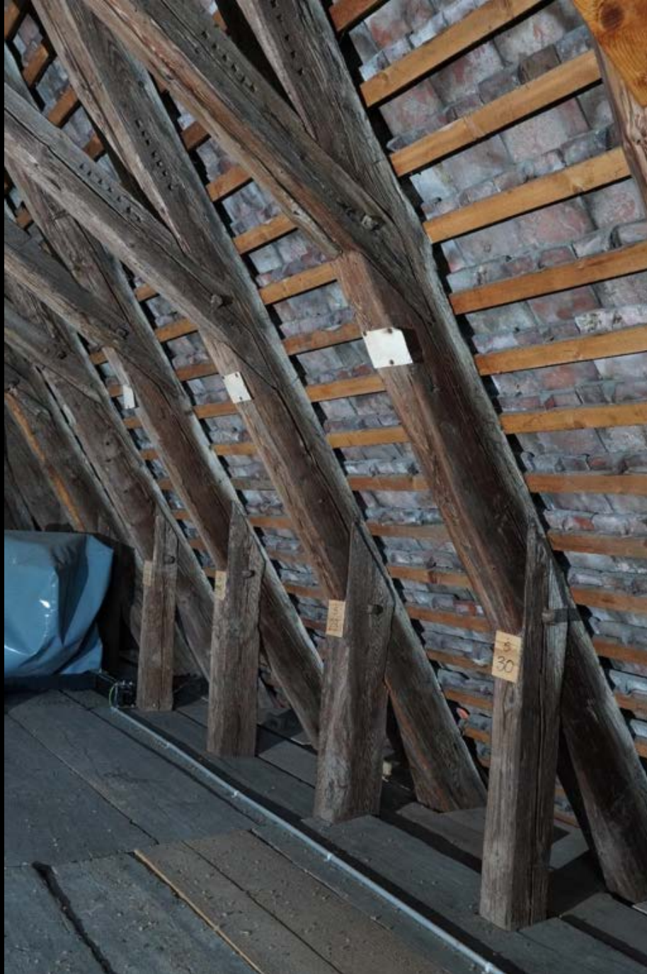
Kreuzstrebendach (Klosterkirche Königsfelden bei Windisch AG, 1315d). Sparrenknechte
