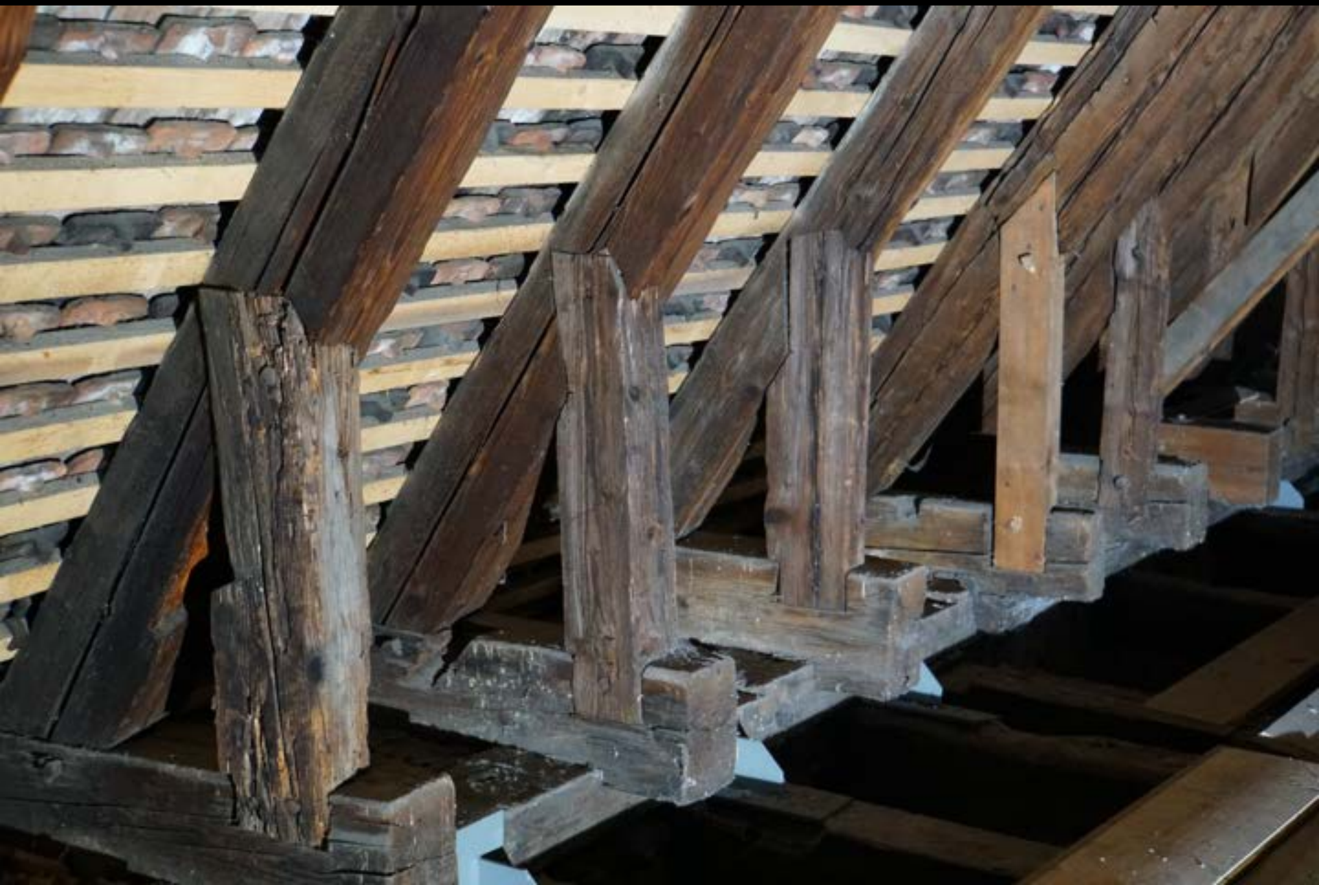
Kreuzstrebendach: Stichbalken Sparrenknechte (Basel, Grosses Klingenthal, 13. Jh.)
