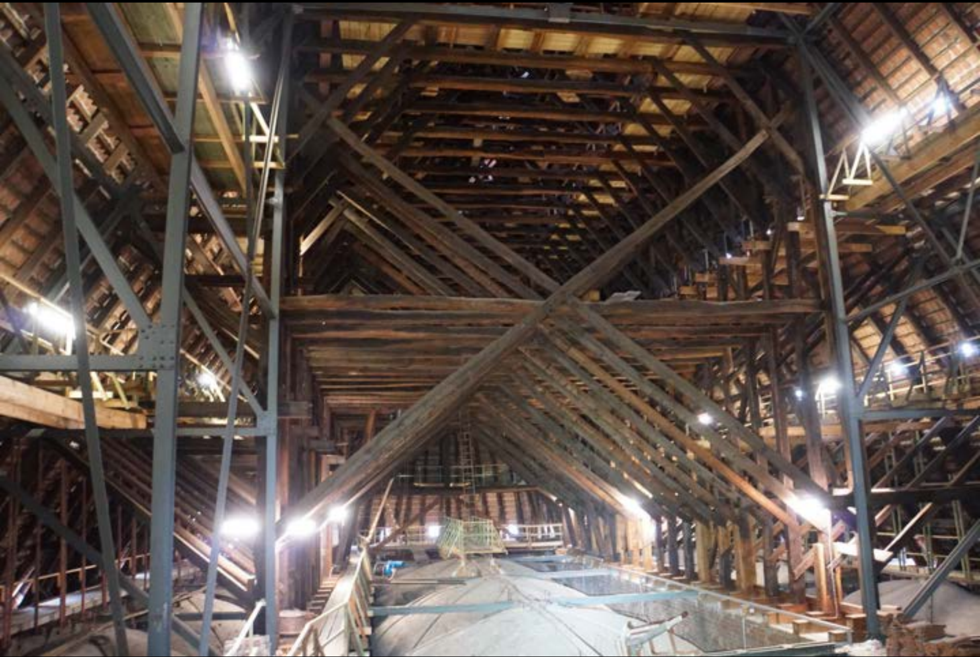
Hannover, Marktkirche. Dachwerk. Aufgeständertes Kehlbalkendach, Kreuzstreben
