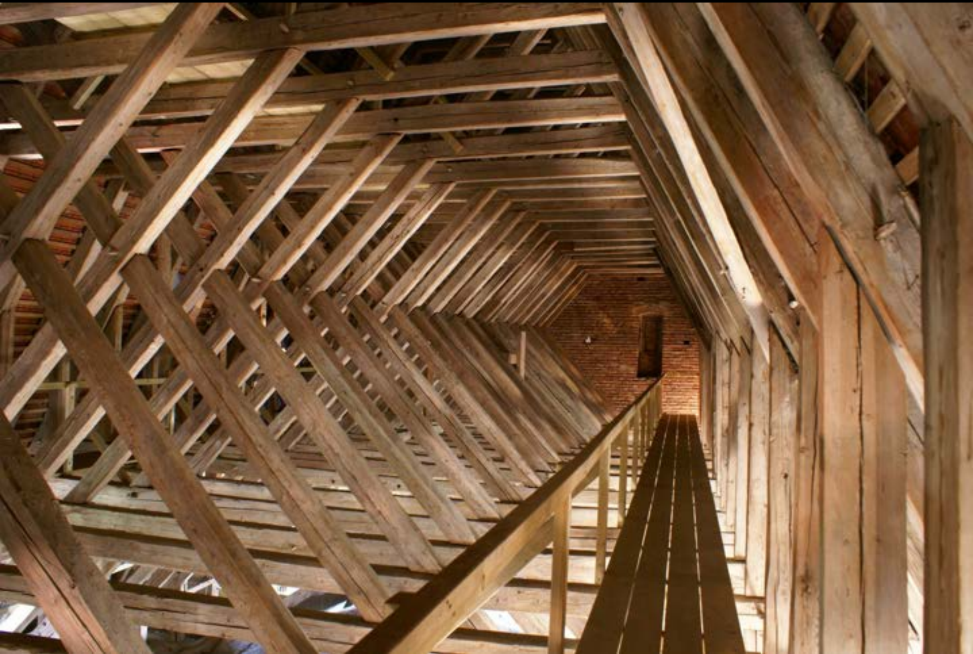
München, Maria Ramersdorf, Langhausdach (14. Jh.)
