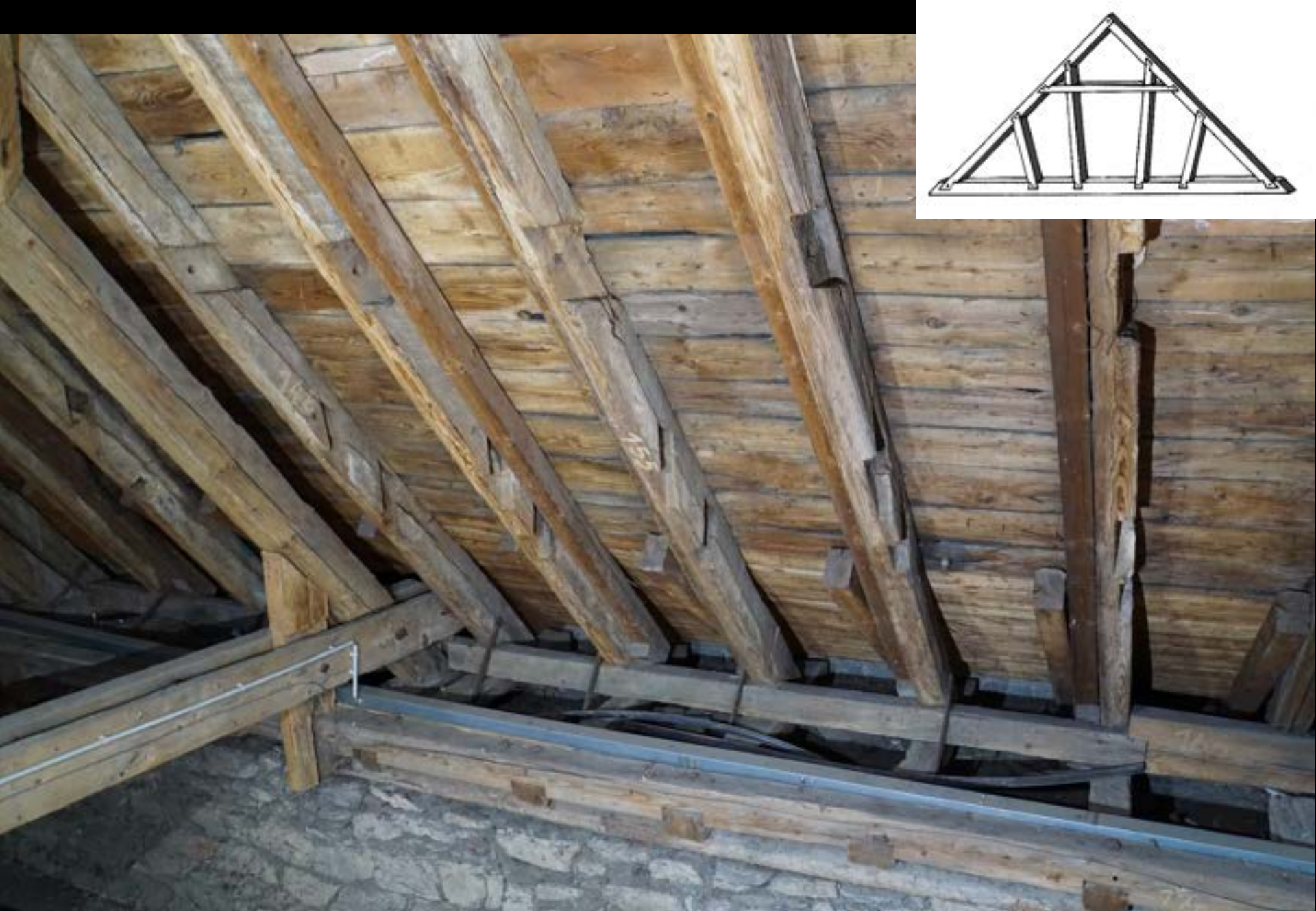
Relikte eines Dachwerks mit Kehlbalken und mehreren Sparrenknechten (Limburg/Lahn, Dom, Südquerhaus, um 1220)
