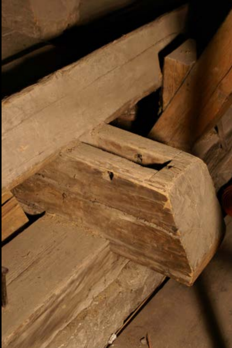
Zapfenloch für einen Sparren mit „abgestirntem Zapfen“
