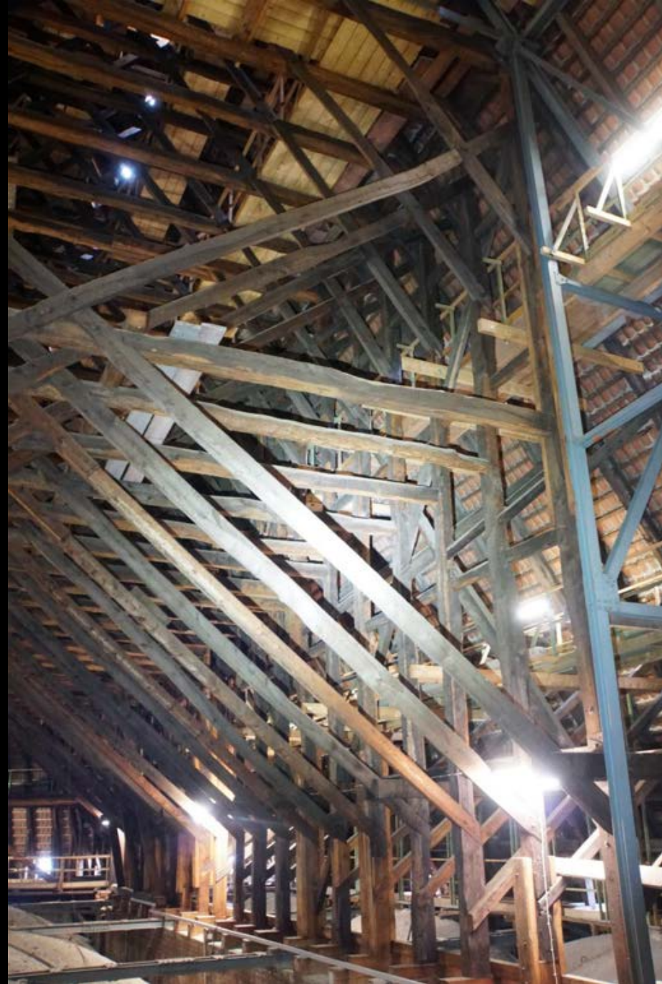
Hannover, Marktkirche. Aufgeständertes Kehlbalkendach, Kreuzstreben
