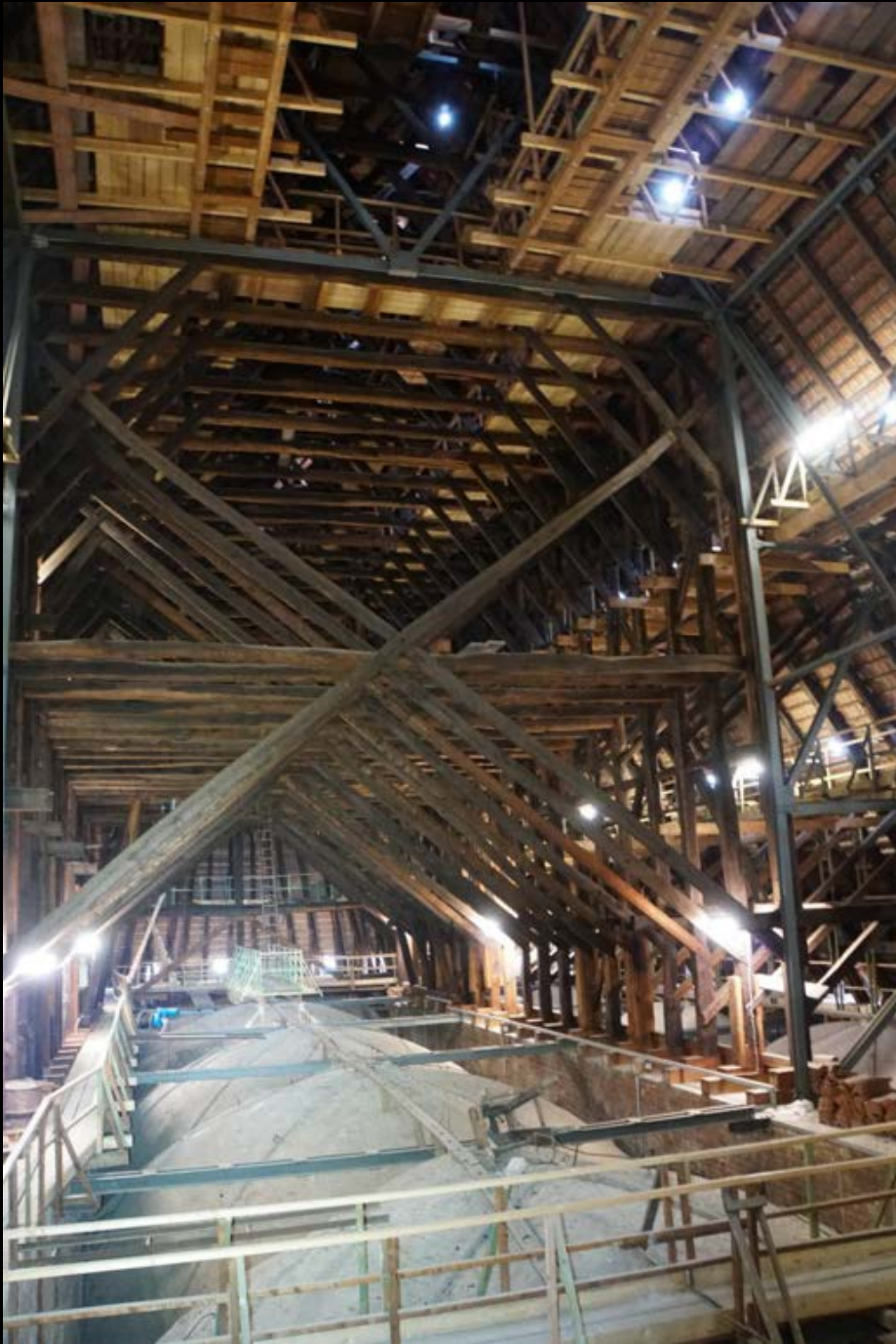
Hannover, Marktkirche. Aufgeständertes Kehlbalkendach, Kreuzstreben
