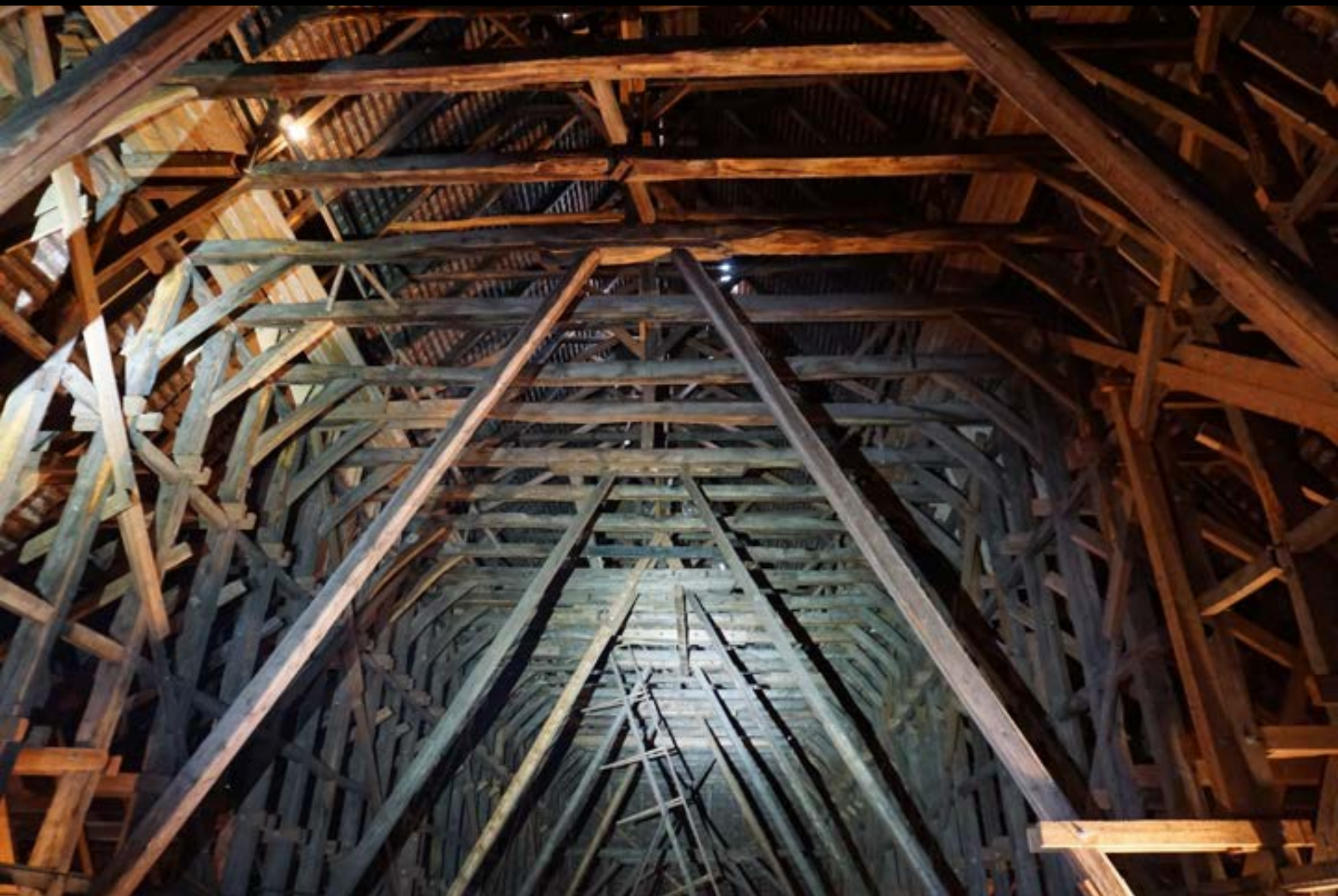
Braunschweig, St. Ägidien. „Aufgeständertes Kehlbalckendach“ mit Ständerwand unter den Kehlbalken.
