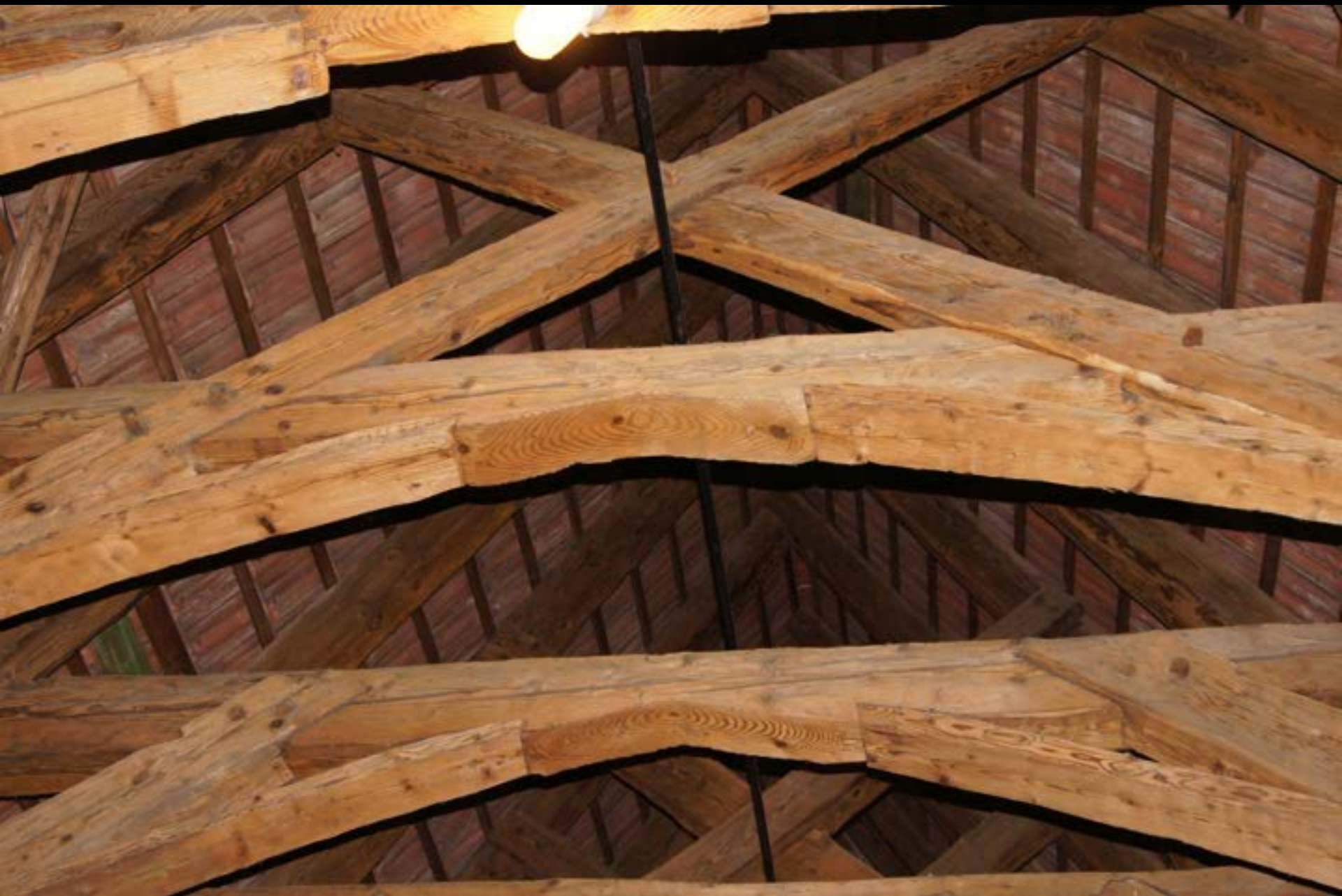
Kreuzstrebdach in Tonnenform (Erfurt, Predigerkloster, 1279)
