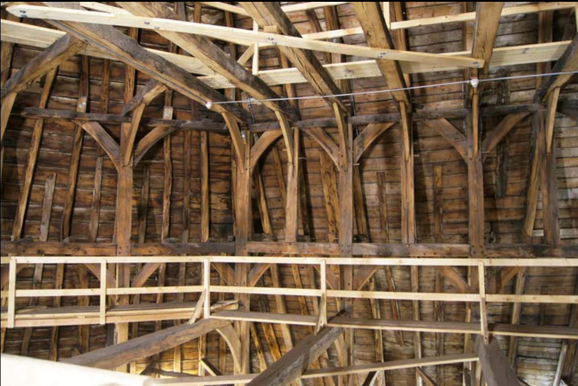
„Aufgeständertes Kehlbalkendach“ bei gotischer Hallenkirche (Ständer in jedem Gespärre!) Lippstadt, Grosse Marienkirche
