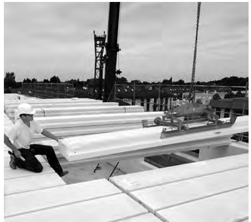
Verlegen von Hebel Dachplatten mit Verlegebügel.
