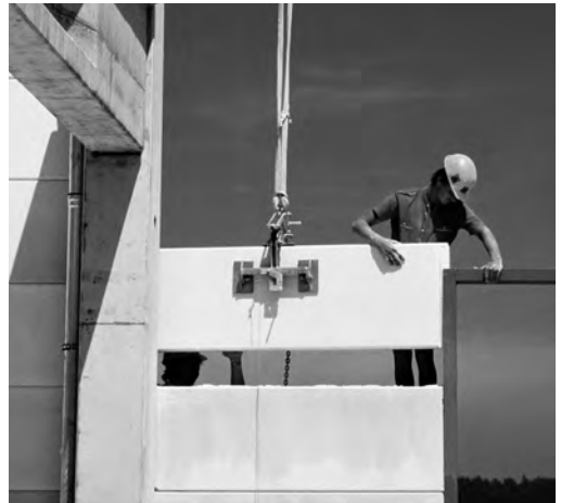
Montage von liegend angeordneten Hebel Wandplatten mit der Plattenzange.
