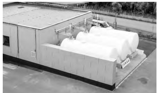
Brandsicherer Anbau an Bestandshalle der Firma Höfer Chemie in Kleinblittersdorf.
