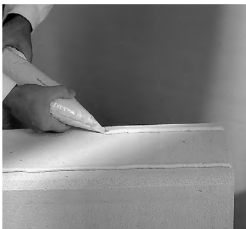
Verklebung von Hebel Wandplatten mit Kleber und Fugenfüller.
