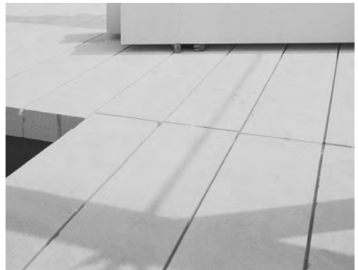
Hebel Deckenplatten auf Stahl-Unterkonstruktion.
