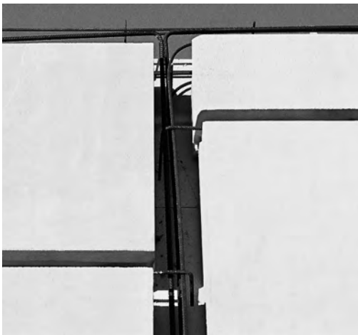
Hebel Deckenplatten mit eingelegter Fugen- und Ringankerbewehrung.
