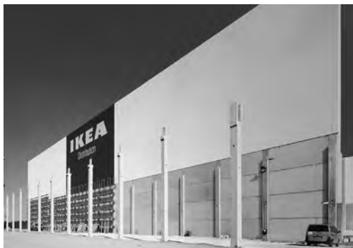
Hebel Komplextrennwände im IKEA Zentrallager Salzgitter.
