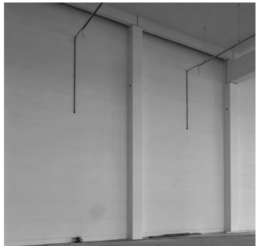
Massive Bauweise mit luftdichten Anschlüssen.
