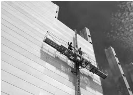
Liegend angeordnete Hebel Wandplatten.
