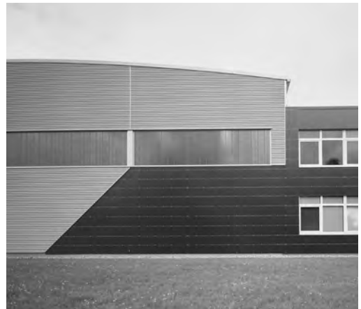
Fassadenelemente auf Porenbeton.
