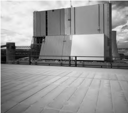
Flachdach aus Hebel Dachplatten.
