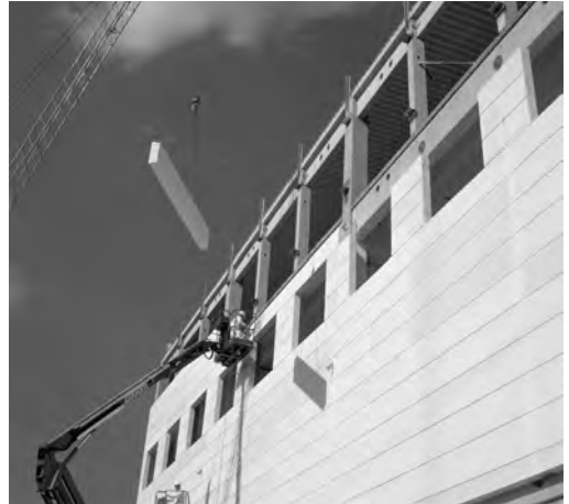
Montage von liegend angeordneten Hebel Wandplatten mit Transportankern.
