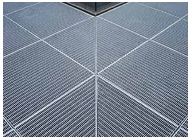
Bild 22: Schrägschnitt bei einem Gitterrost
