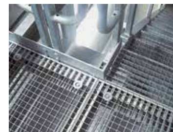
Bild 35: Fußleiste auf der Konstruktion
