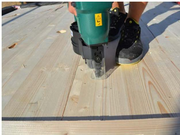
Montage einer Decke mit Magazinschrauber
