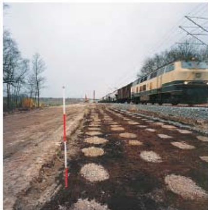
Aushubsohle nach Rüttelstopfverdichtung
