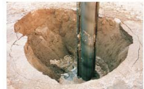
Rüttler mit Absenktrichter
