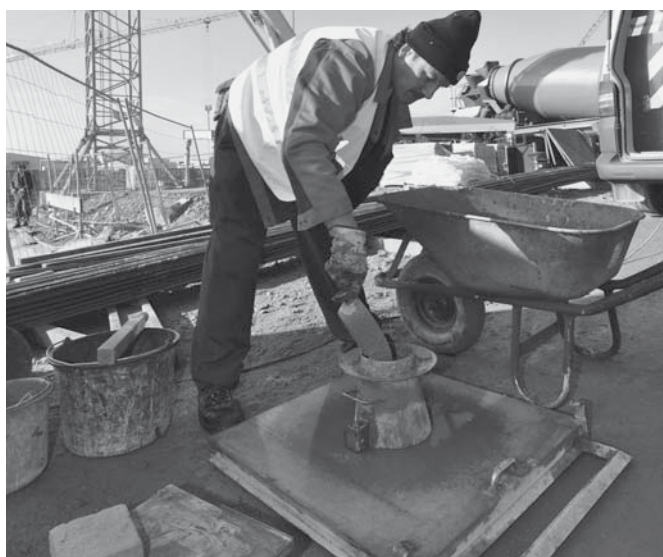
Bild 2: Auf der Baustelle wird u.a. die Frischbetonkonsistenz geprüft.
