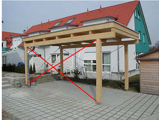
Fehlende Aussteifung - 3 Auskreuzungen erforderlich
