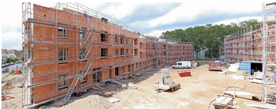
Abb. 5: Die Liebhöfe sind monolithisch mit dämmstoffgefüllten Poroton Ziegeln „S10-MW“ in der Stärke 42,5 Zentimeter errichtet. Dieser Ziegel ist durch seine hohe Druckfestigkeit und die Wärme-, Brand- und Schallschutzeigenschaften prädestiniert für den Einsatz im Geschosswohnungsbau.
