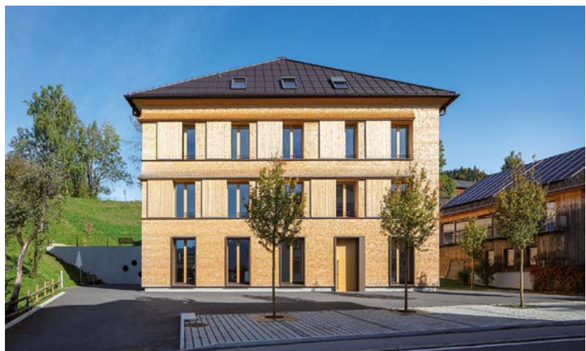
Abb. 4: Das Konzept 2226 lässt vielfältige Fassadengestaltungen zu. Neben Putz oder Klinker können auch Schindeln angebracht werden wie hier in Lingenau.
