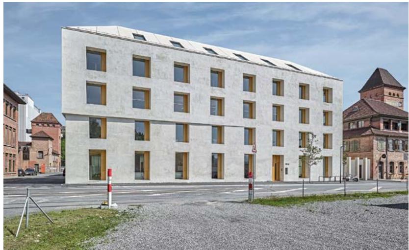
Abb. 3: Bürogebäude 2226 Emmenweid in der Schweiz: ein viergeschossiger Mauerwerksbau mit Kalkputzfassade. Anstelle einer aufwendigen Gebäudetechnik setzten die Planer auf einen rein bauphysikalischen Ansatz.
