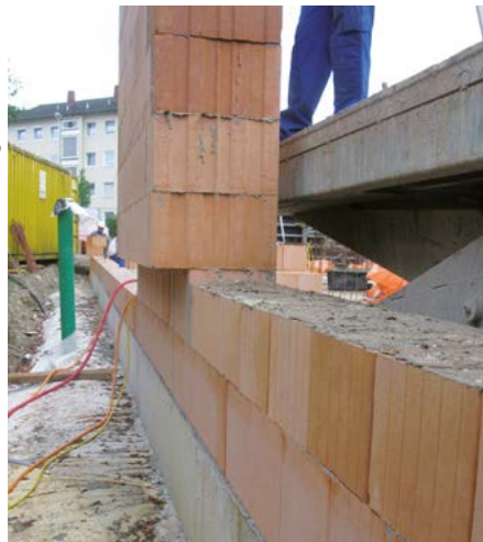
Abb. 3: Reduzierte Wanddicke im Sockelbereich: Ausführungsbeispiel im Rohbau
