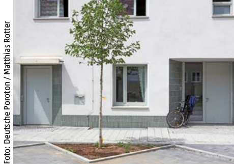
Abb. 3: Die schräg ausgeführten Laibungen der Eingänge sowie der Sockelbereich sind wartungsarm gefliest. Farbe und Materialität der grün glasierten Verblender setzen einen Akzent zur hellgrauen Lochfassade.
